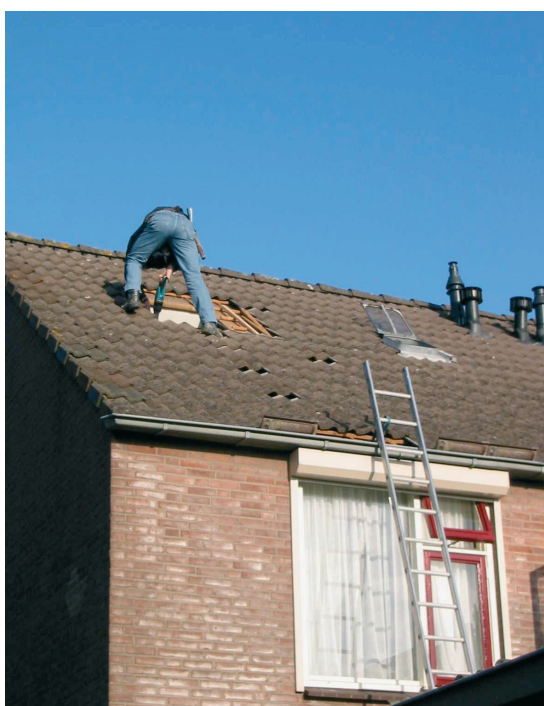
Foto: werken op een schuin dak brengt veel risico's met zich mee. In deze situatie is de ladder verankerd maar de persoon niet.
