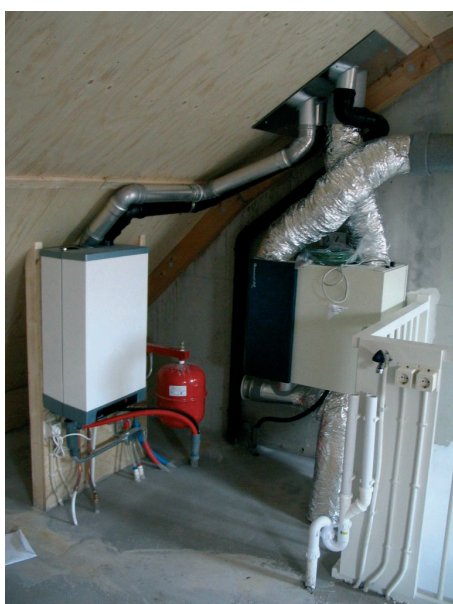
Foto: vooral in kruipruimten en ruimten waar installaties zijn opgesteld is vaak beperkte werkruimte aanwezig.
