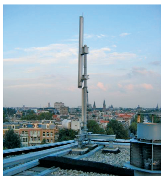
Foto: bij het werken aan een GSM-mast dient de mast tijdelijk buiten werking te worden gesteld.
