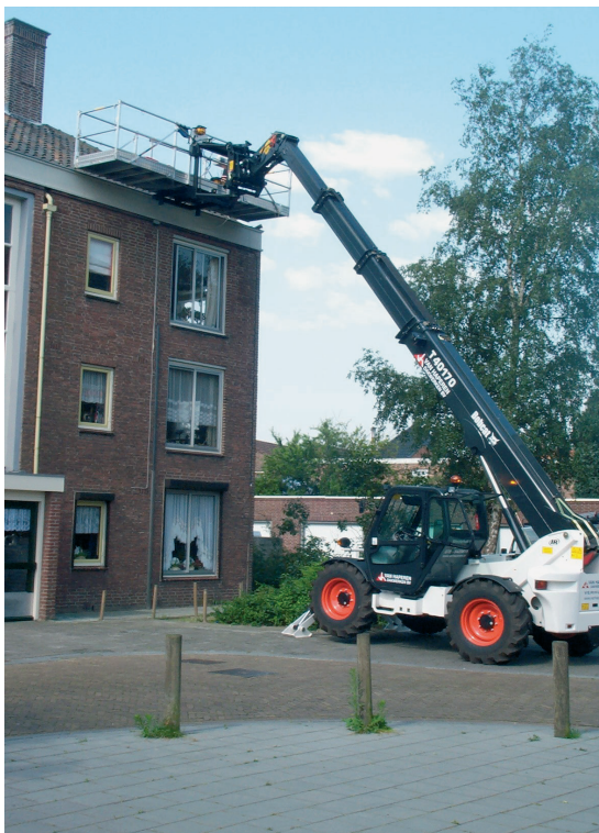
Foto: het heeft bij werkzaamheden op hoogte de voorkeur gebruik te maken van tijdelijk leuningwerk boven pbm's.
