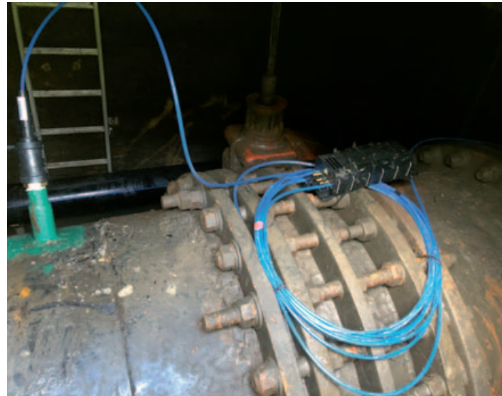
Met behulp van specifieke Frialen elektrolassettingen, ontwikkelde Vigotec een systeem waarmee de glasvezel in en uit leidingen wordt geleid.
