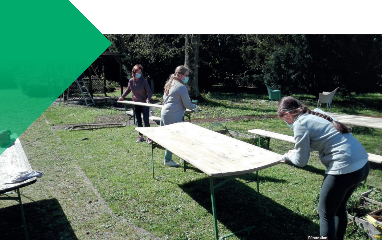
Rénovation d'une pergola
