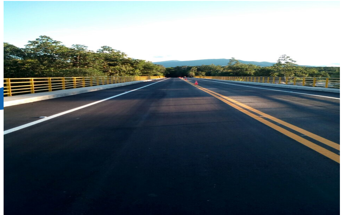
Puente Curipao Sácama-La Cabuya-La Cabuya- Saravena (Arauca)
