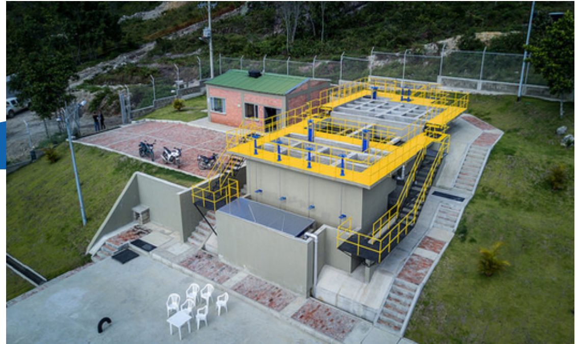
Planta de tratamiento de agua potable Gramalote Norte de Santander
