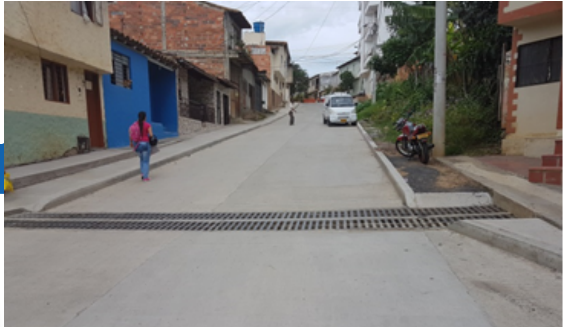
Alcantarillado Pluvial y Sanitario - Calle 19 Socorro - Santander
