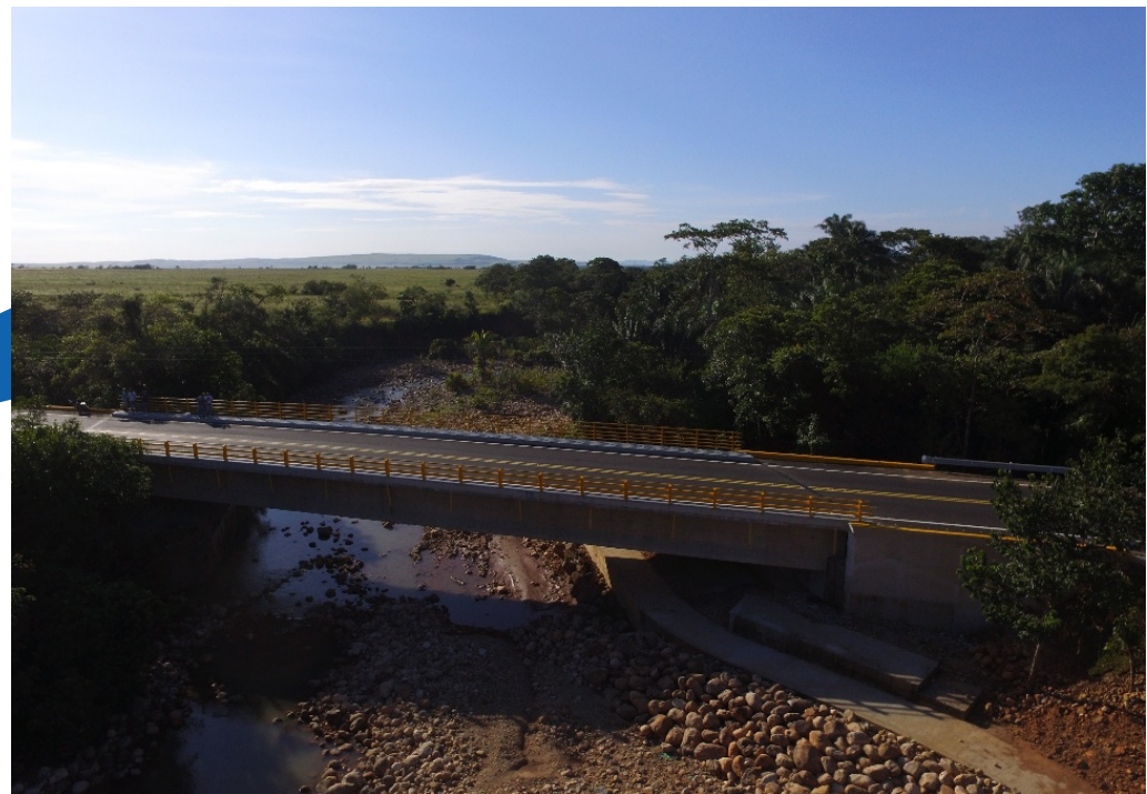
Puente Vehicular Tocoraguita Vía Sácama –La Cabuya (Arauca)
