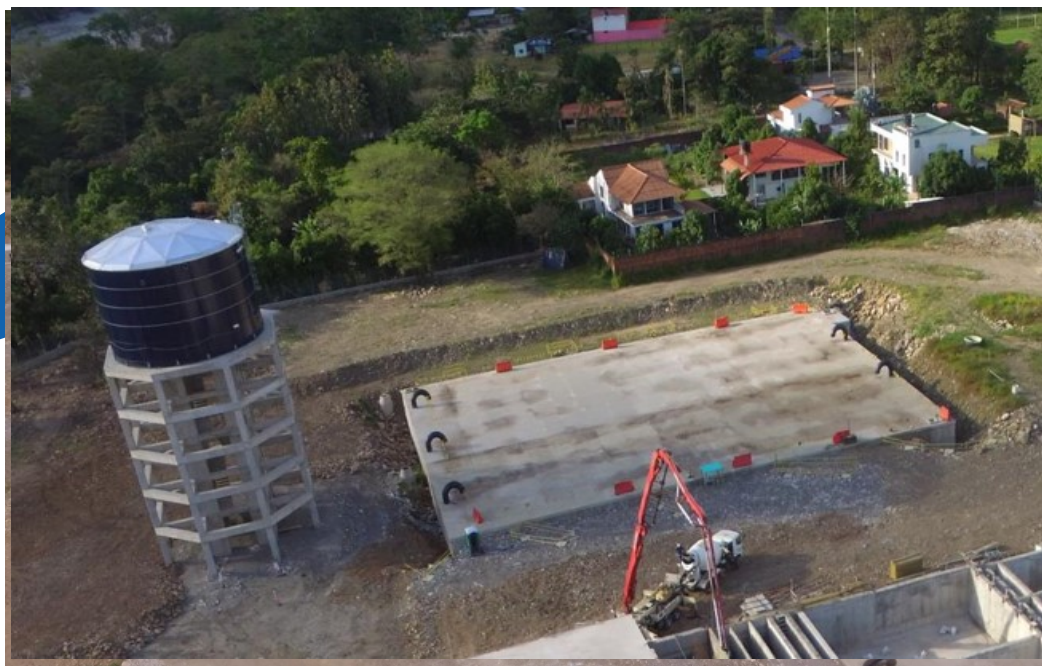
Construcción sistema de abastecimiento de agua y planta de tratamiento de agua potable Yopal - Casanare
