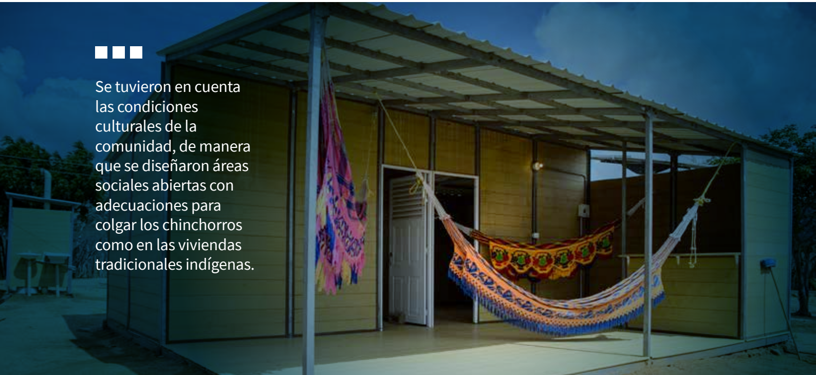
Casa del proyecto Siapana en la Alta Guajira Foto: Wilfredo Amaya/ Fondo Adaptación
