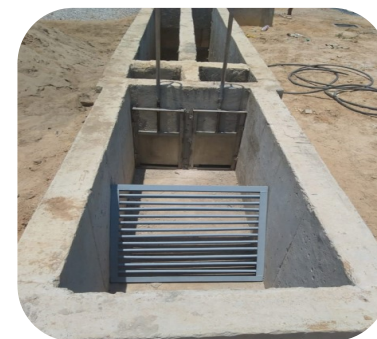
Alcantarillado Astrea (Cesar)
