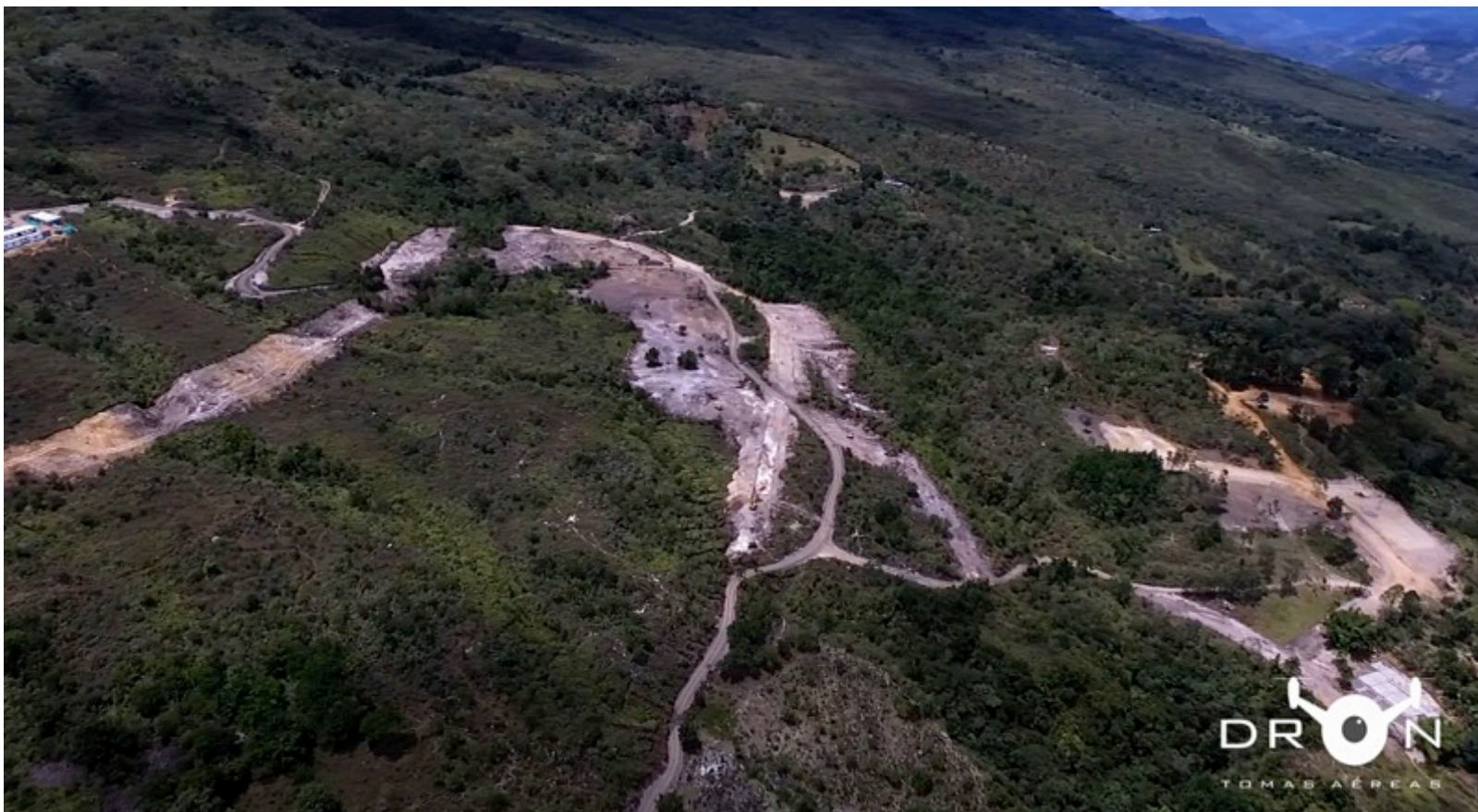
VISTA PANORÁMICA DE LA OBRA
