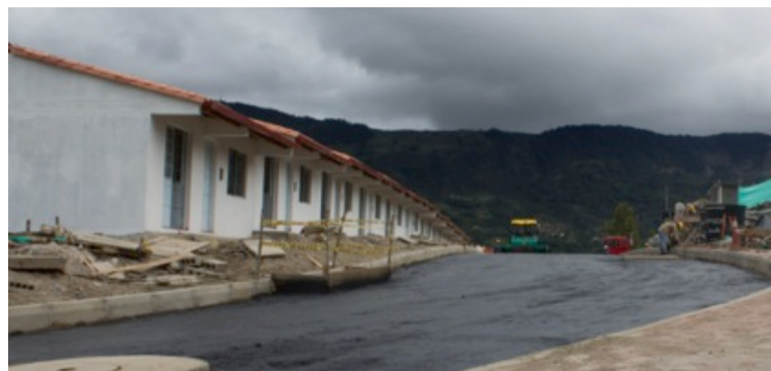
Pavimentación vías interbarriales
