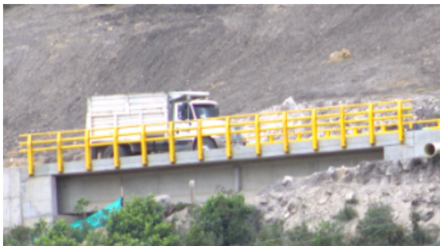
Puentes sobre vías urbanas
