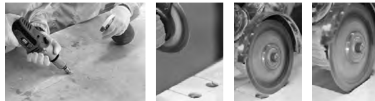
Öffnungen in den Ecken herstellen, um ein mögliches Brechen der Fliese zu vermeiden
