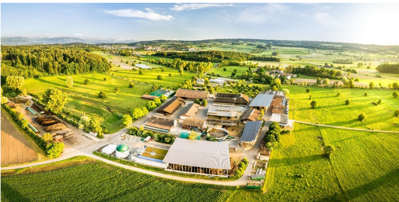
Bild: Murimoos aus der Luft – Dachflächen mit Potenzial
