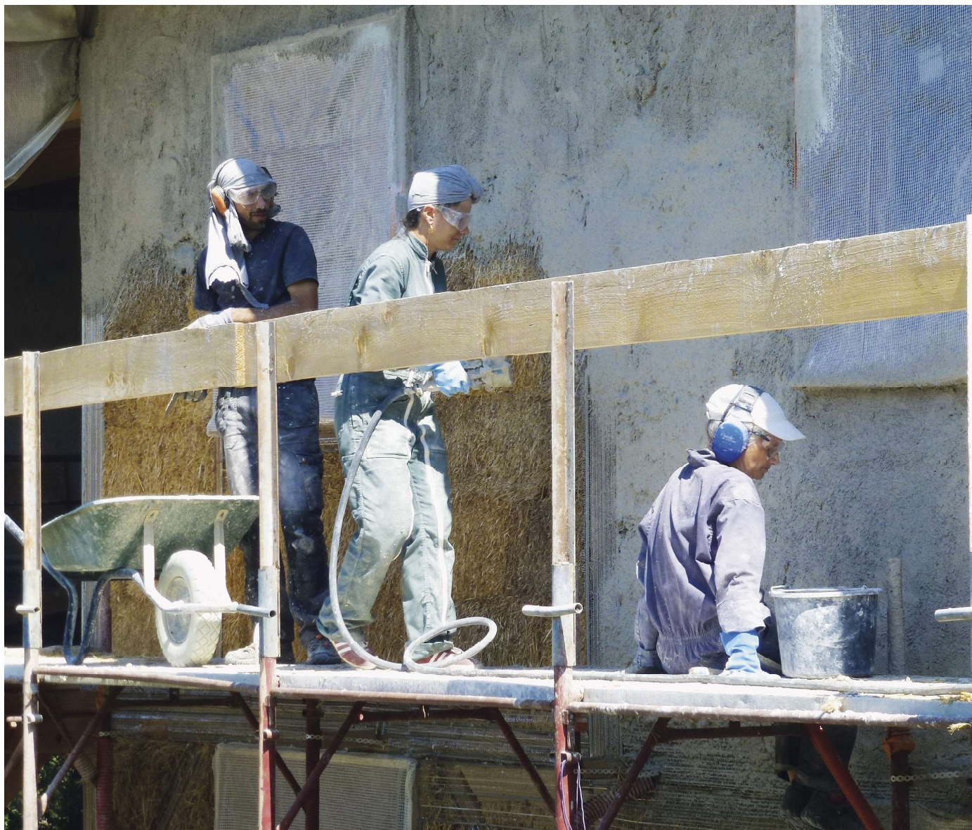
In den Kursen können auch Verputzarbeiten gelernt werden.
