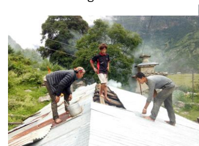
Umbau zum Prok Kindergarten 2019
