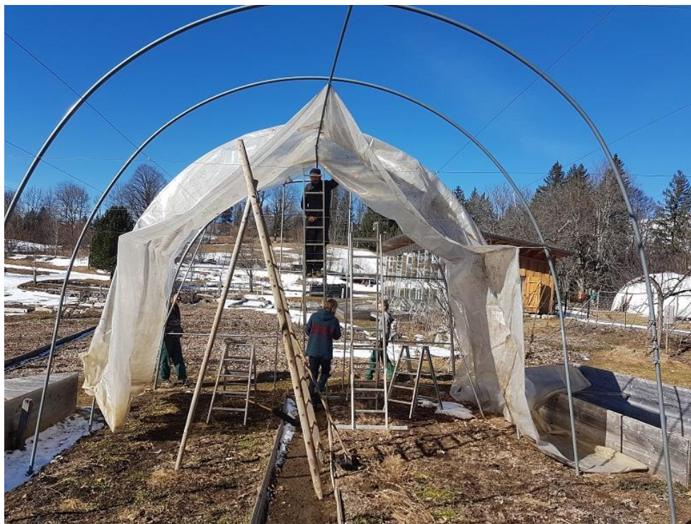
Aufbau des Folientunnels in Teamarbeit
