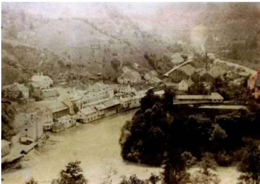
Abb. $139$: Die Messingfabrik in Reichraming (links) 1869, vor dem Eisenbahnbau. (nach Brunnthaler 2009, Abb. 26; Scan Adolf Brunnthaler)
