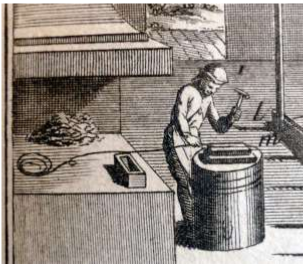
Abb. $107$: Teil einer Drahtziehwerkstatt: Der Mann schmiedet mit einem kleinen Hammer das Ende eines Rohdrahts dünner, damit dieser in das nächstkleinere Loch des Zieheisens (Abb. $108$) eingeführt werden kann. (nach Diderot/d'Alembert 1780, Taf. 3, Ausschnitt oben links)
