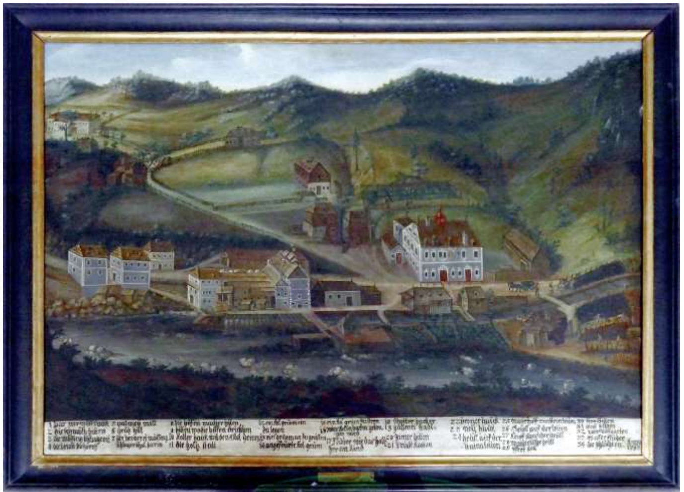
Abb. $2$: Aussenansicht des Messingwerkes Reichraming/A (Innenansicht: Abb. $2$) am Reichramingbach, dessen Wasserkraft zum Mahlen der Galmei (Abb. $24$), für die Dreh-Schleifsteine (Abb. $29$) und für die Hammerwerke (Abb. $25$; $31$) genutzt worden ist. Ölbild von 1763, aufbewahrt im Stift Seitenstätten/A. Bildgrösse ohne Rahmen: 95,7×70,5 cm.
