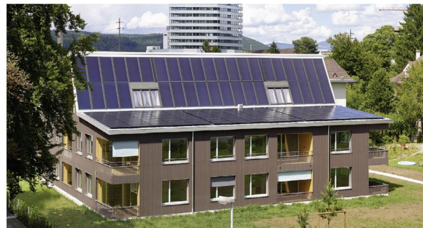
1 Das MFH in Pratteln produziert mit der nach Süden gerichteten 30 kW starken PV-Anlage jährlich 21'900 kWh/a für 12 Alterswohnungen.
