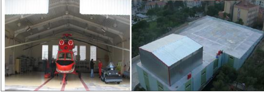
Resim 2.3: Hangar ve heliportun yukarıdan görünüşü
