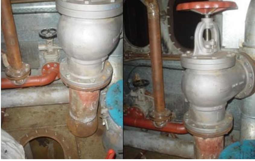
Resim 2.2: Makine dairesi sintinesini emen gönye vana
