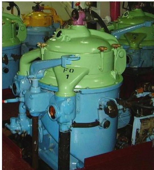
Resim 4.1: Makine dairesindeki separatörler
