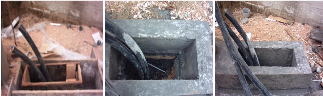
Resim 4.6: Ölçüm panosu beton platform (kaide) hazırlanması
