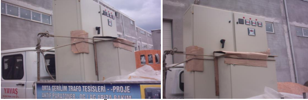
Resim 4.5: Ölçüm panosunun montaj yerine taşınması
