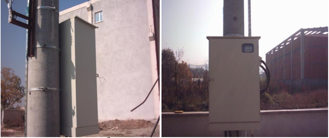
Resim 4.2: Ölçüm panosu beton trafo direğinde montajlı
