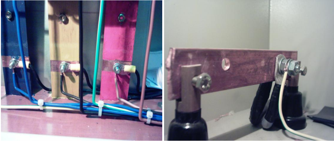
Resim 3.7: Gerilim klemenslerine baradan bağlantı ve nötr barasına bağlantı
