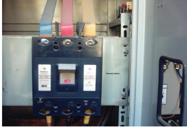
Resim 2.5: Şalterin yekpare tip tablaya montajlı hâli
