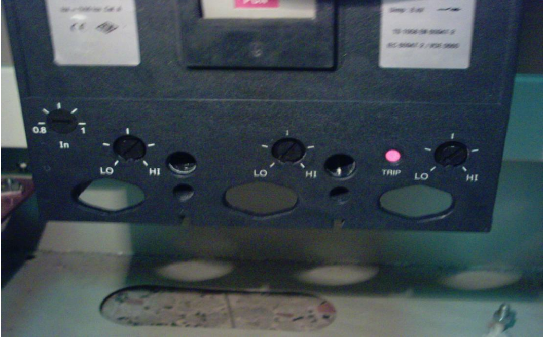
Resim 4.11: Kompakt şalter ayar bölümü ve trip butonu
