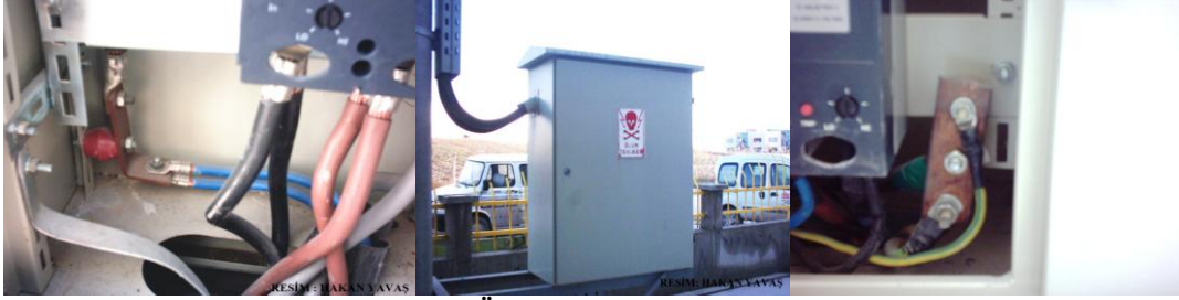
Resim 4.12: Ölçüm pano kablo bağlantıları
