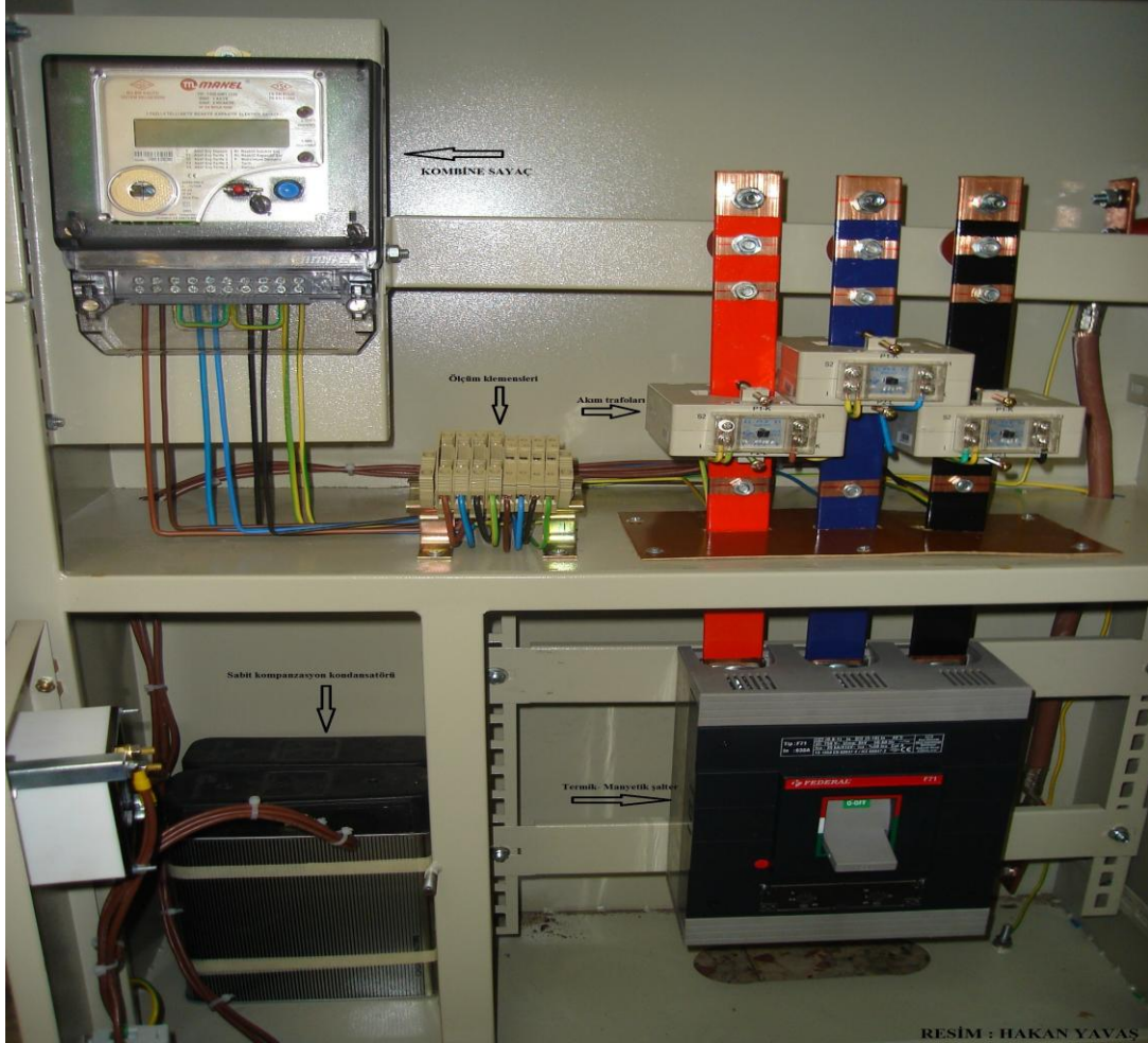
Resim 3.1.b: Ölçüm panosu bağlantıları
