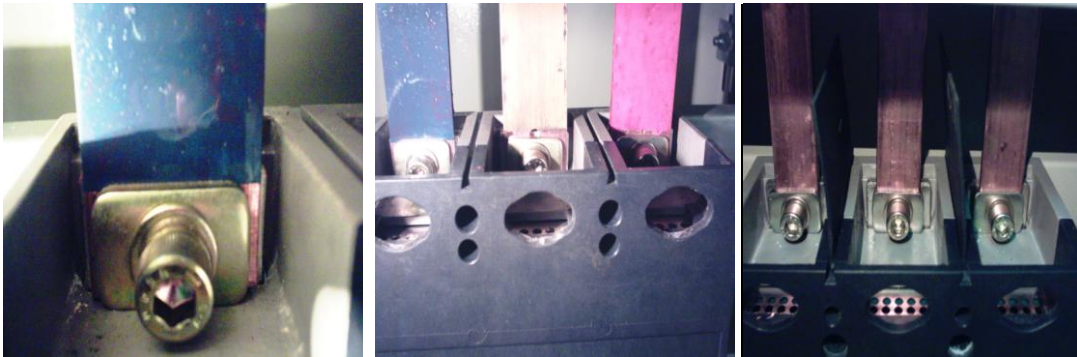
Resim 3.4: Baraların şalter girişlerine tutturulması
