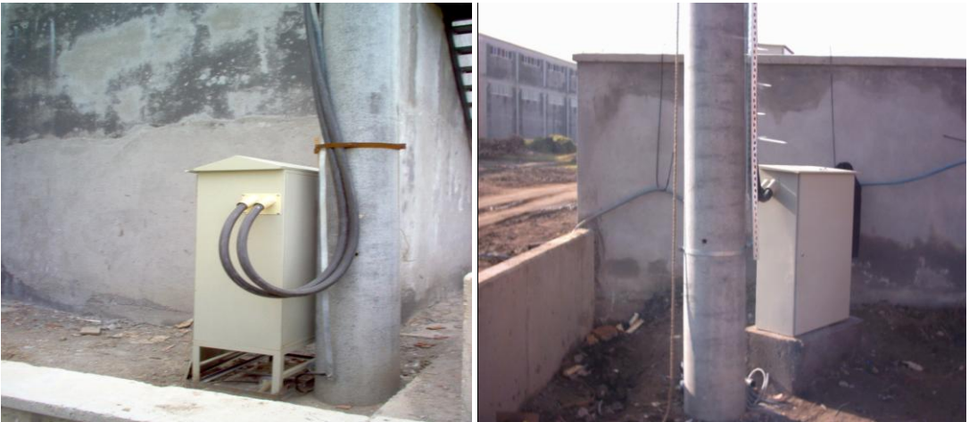
Resim 4.4: Ölçüm panosu direk dibinde zeminde demir ve beton platforma montajlı
