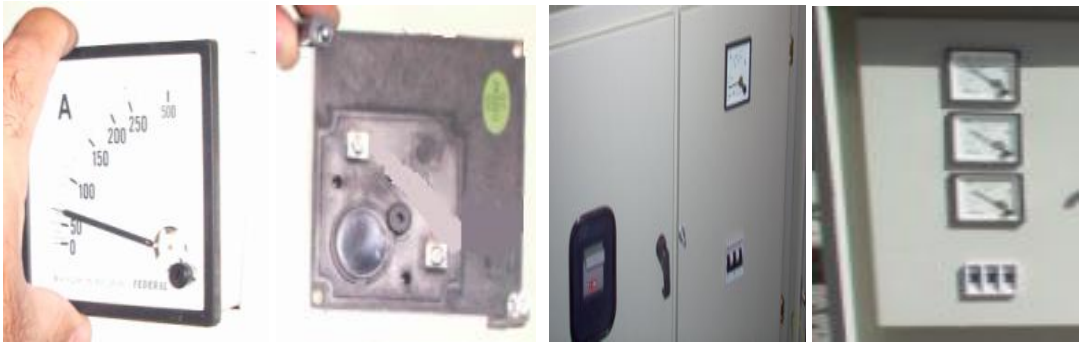
Resim 2.11: Ampermetre montajı ve montaj yapılmış hali
