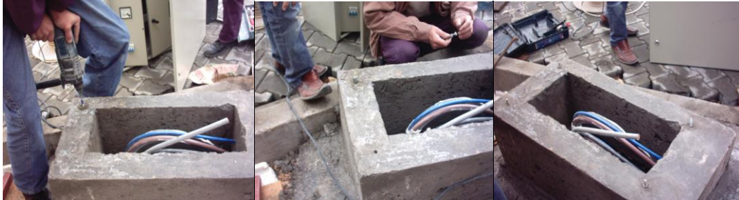
Resim 4.7: Ölçüm panosu beton kaideye montaj yerlerinin hazırlanması
