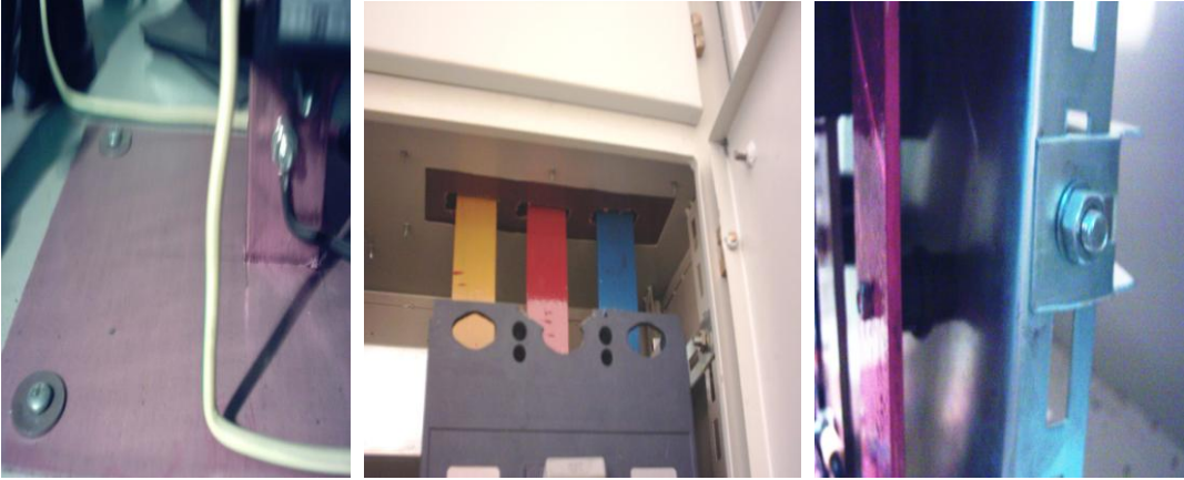
Resim 3.3: Bara yalıtma fibri, baraların geçişi ve panoya izolatörle sabitlenmesi
