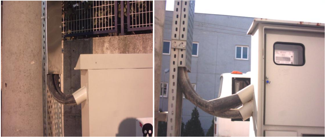
Resim 4.9: Ölçüm panosuna direktten kablo girişi
