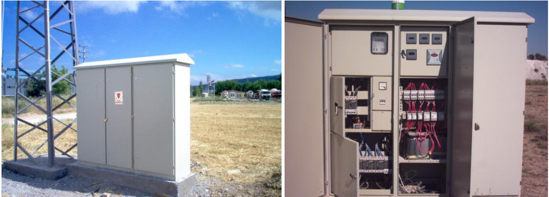
Resim 4.1: Ölçüm panosu ve AG kompanzasyon panosu
