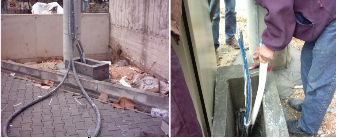
Resim 4.8: Ölçüm pano giriş çıkış kabloları ve yalıtkanının soyulması
