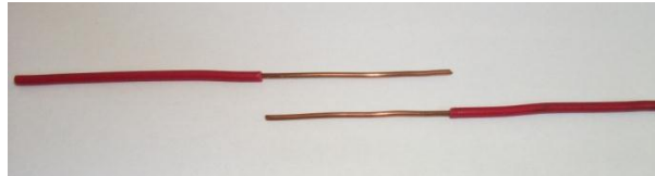
Resim 1.14: İletkenlerin uçlarının izole kısımlarının soyulması
