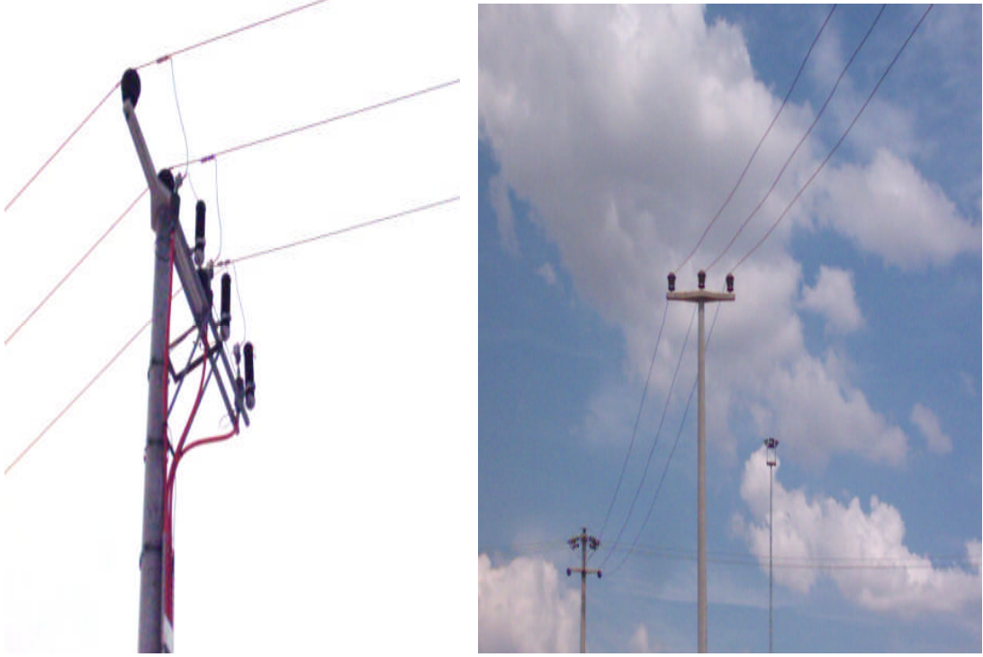
Resim 1.15: OG beton direkler
