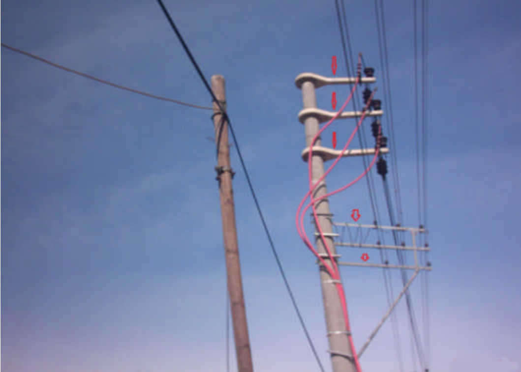
Resim 3.3: Beton ve demir konsollar
