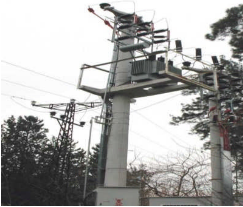
Resim 1.16: OG beton trafo diređi
