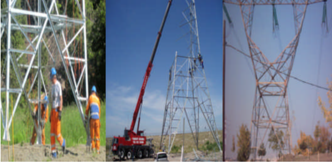
Resim 2.6: ÇY Gerilim demir direk temelden örülerek (profil parçalar vidalanarak) montajı
