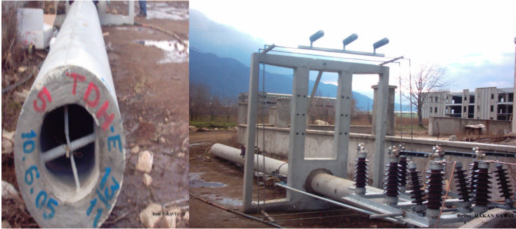
Resim 2.8: Santrifüj direk (SBA) ve beton trafo direği
