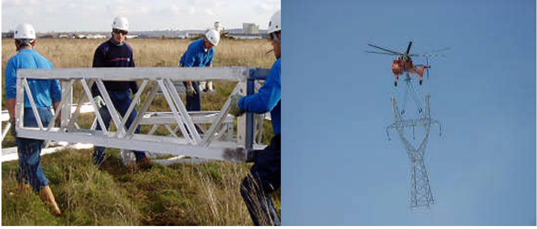
Resim 2.3: Demir direk montaj yerine getirilmesi
