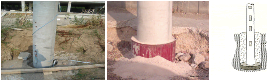
Resim 2.9: Santrifüj direk (SBA) , vibre direk temeli ve dikilmesi
