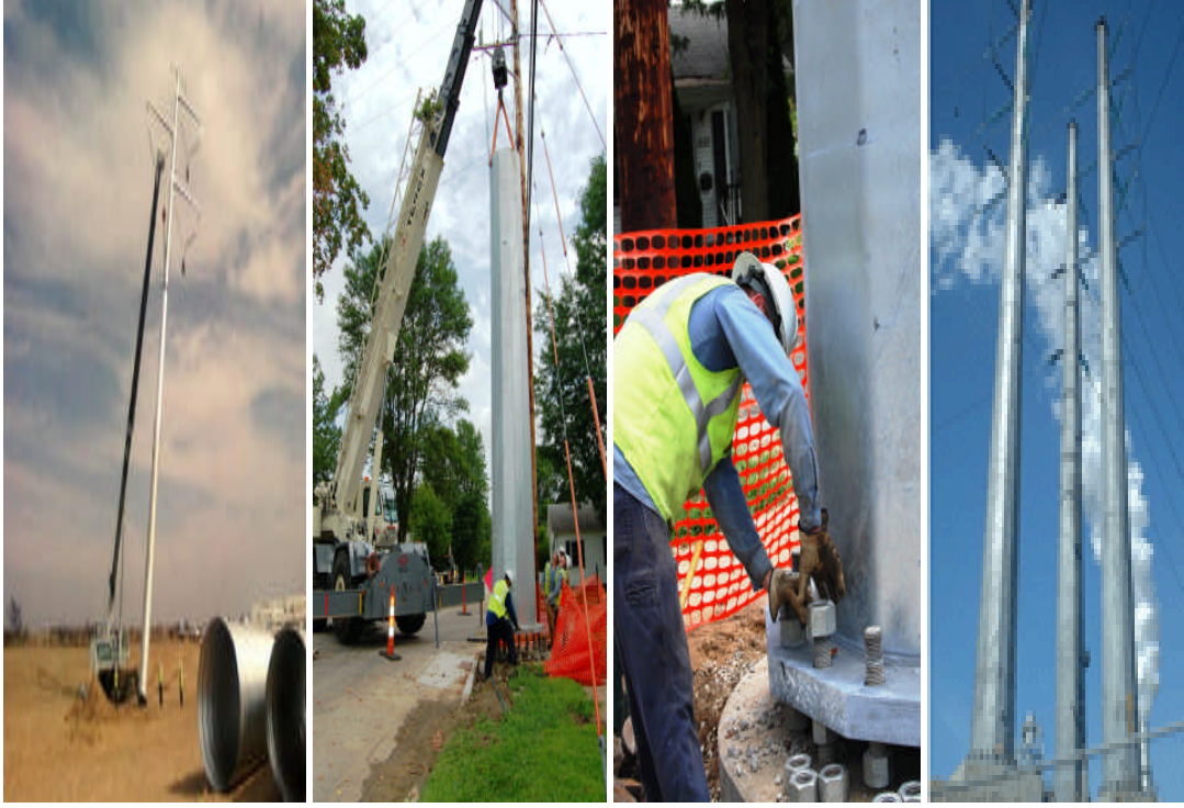
Resim 2.10: Demir-galvaniz direk montajı
