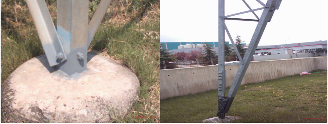
Resim 2.4: Çok yüksek gerilim demir direk ayaklarının betonla zemine tuturulması
