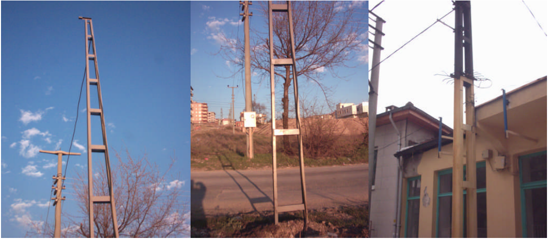
Resim 1.3: A tipi demir direkler
