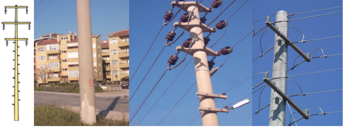
Resim 1.9: Santrifüj (SBA) yuvarlak tip beton direkler
