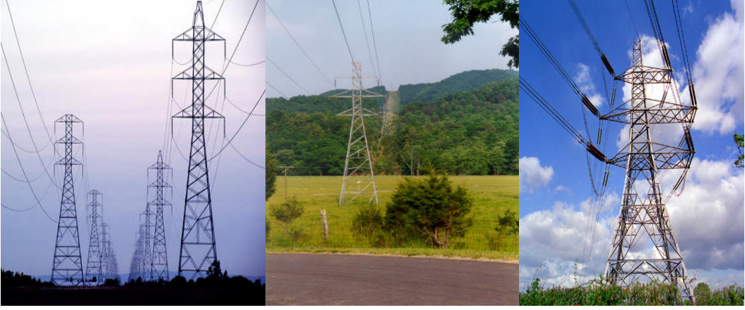
Resim 1.5: Pilon tipi demir direkler
