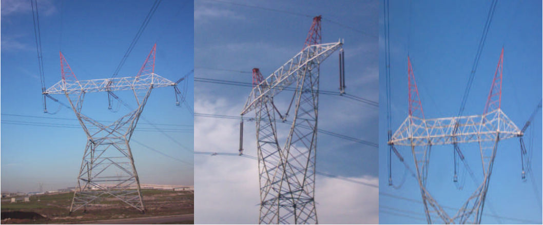
Resim 1.6: Çatal tipi demir direkler
