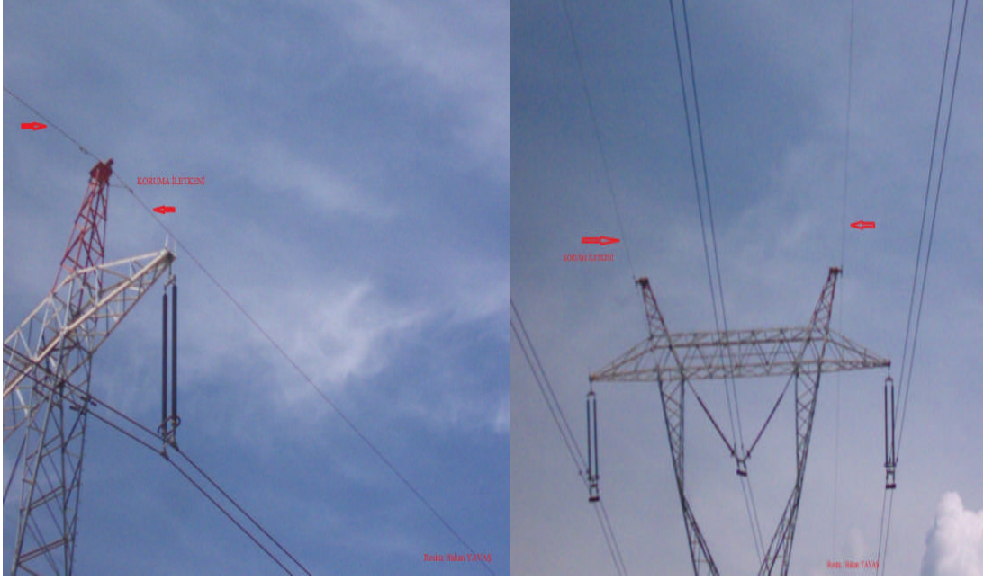
Resim 1.25: Koruma iletkeni
