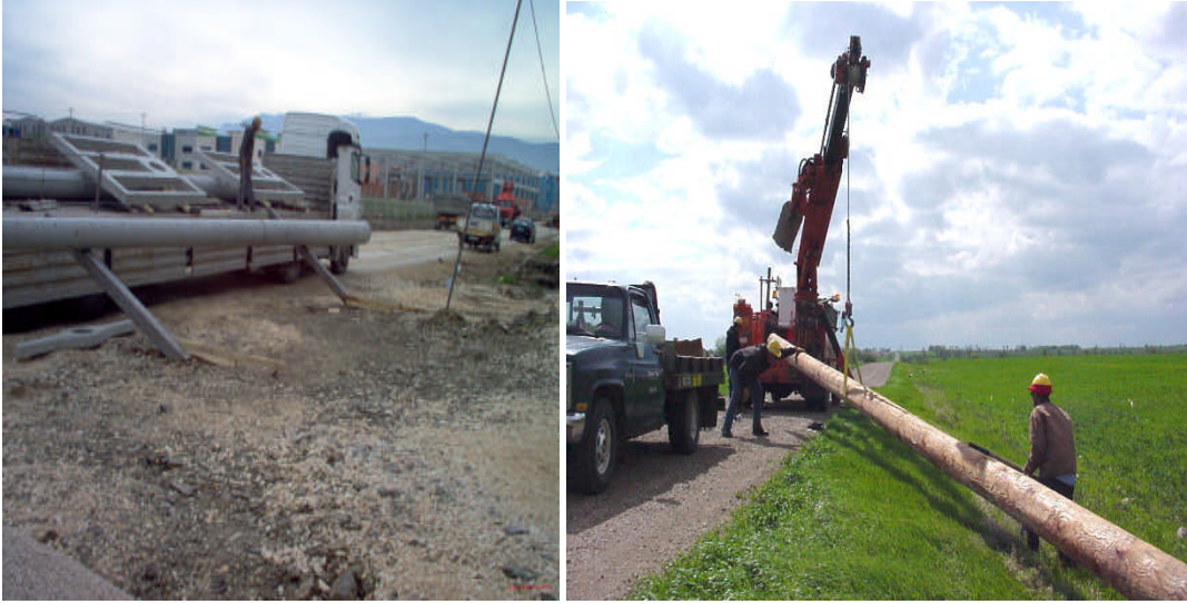
Resim 2.2: Beton ve ağaç direk montaj yerine getirilmesi
