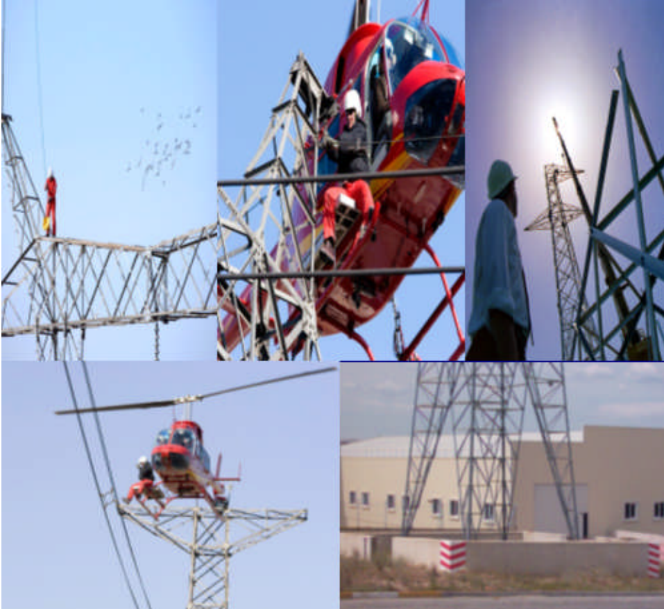
Resim 2.7: YG demir direk montajı
