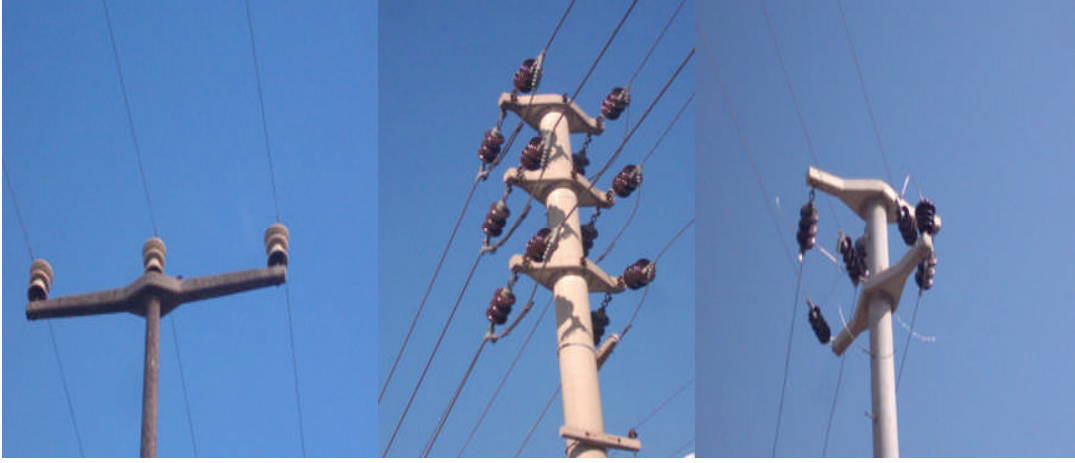
Resim 3.1: Direklerde beton traversler
