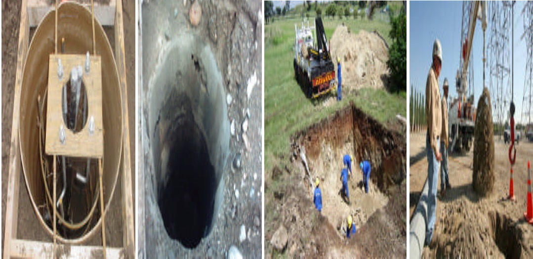
Resim 2.1: Boru tipi galvaniz- beton- pilon demir direk temelleri
