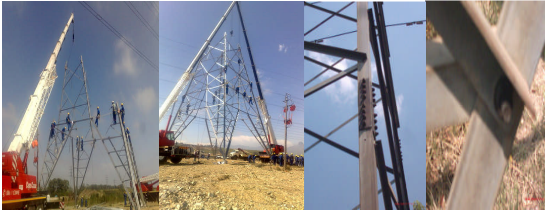
Resim 2.5: ÇY Gerilim demir direk temelden örülerek ( profil parçalar vidalanarak) montajı
