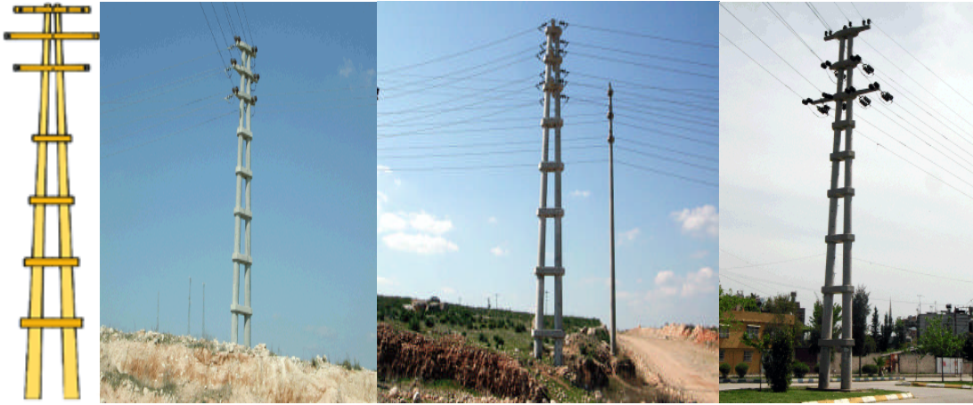
Resim 1.10: Çift santrifüj beton direkler
