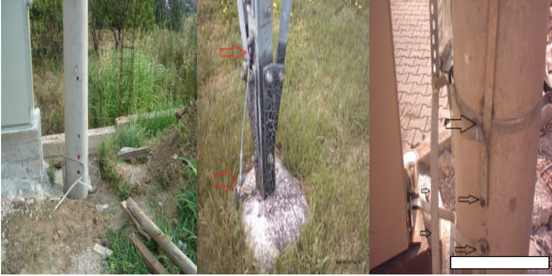
Resim 2.12: Beton direk topraklaması
