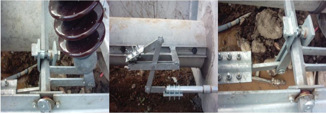
Resim 2.2: Ayırıcı kumanda mekanizmasının montajı
