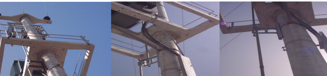
Resim 2.4: Harici ayırıcı kumanda mekanizma kolu
