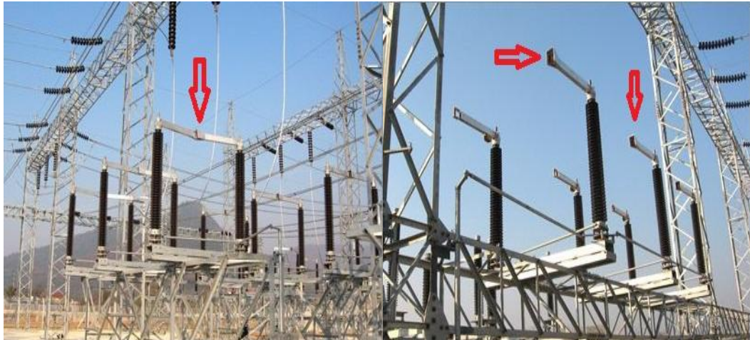
Resim 1.8.b: Ortadan açmalı ayırıcılar
