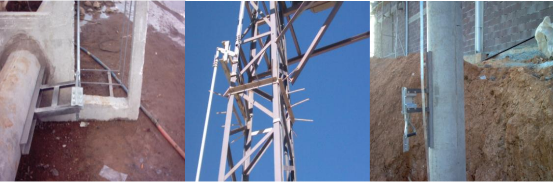
Resim 2.3: Ayırıcı kumanda mekanizma kolu
