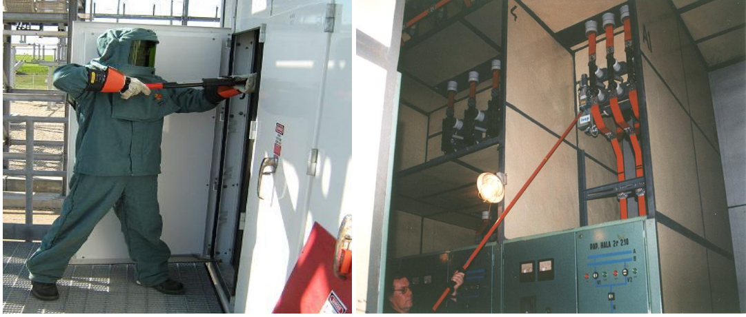
Resim 1.15: Elle kumandalı (ıstankalı) ayırıcı
