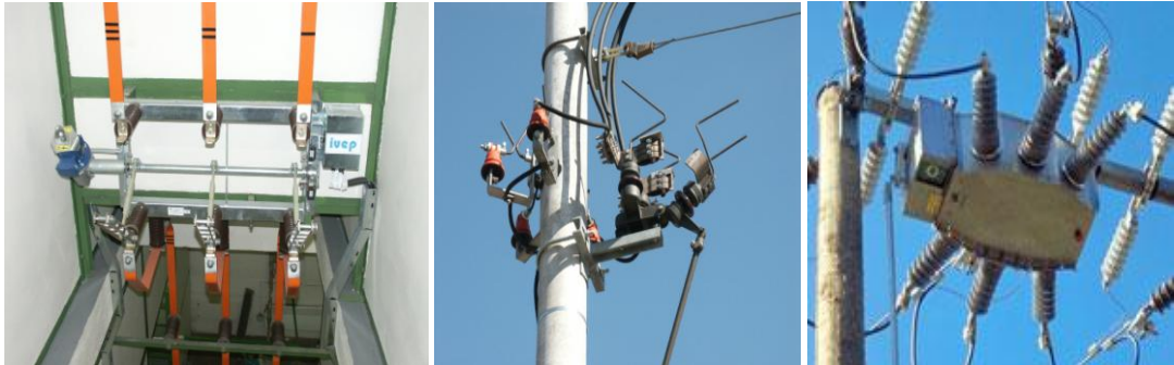
Resim 3.7: Ayırıcıların bağlantıları
