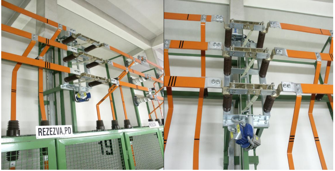
Resim 2.5: Dâhili tip ayırıcı açık hücreye montajı
