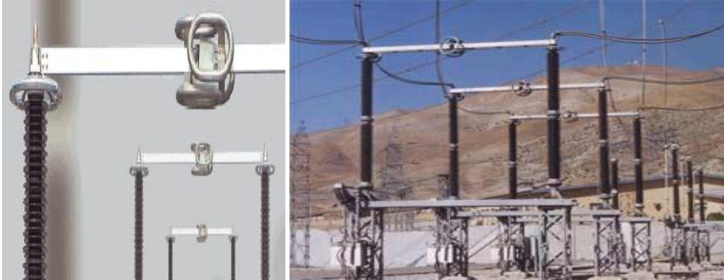
Resim 1.8.a: Ortadan açmalı ayırıcılar
