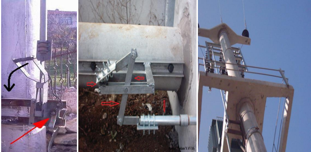
Resim 1.16: Mekanik kumandalı ayırıcılar
