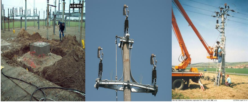
Resim 2.6: Şalt sahası ve direğe ayırıcı montajı
