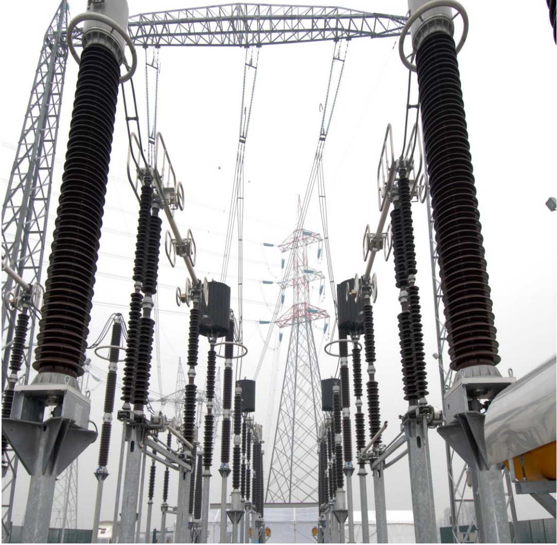
Resim 3.5: Şalt saha ayırıcı bağlantıları
