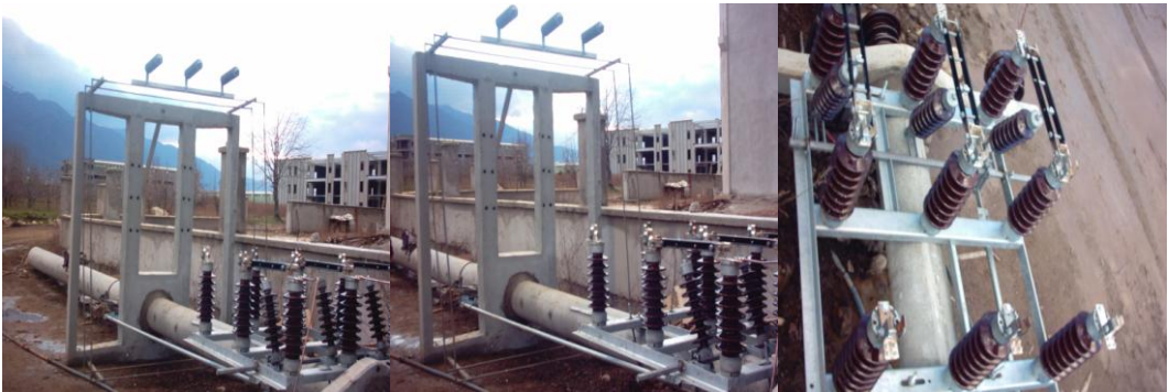
Resim 2.7: Yerde bulunan direğe ayırıcı montajı
