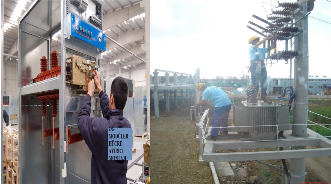
Resim 2.8: OG modüler hücre ve direk üzerine ayırıcı montajı
