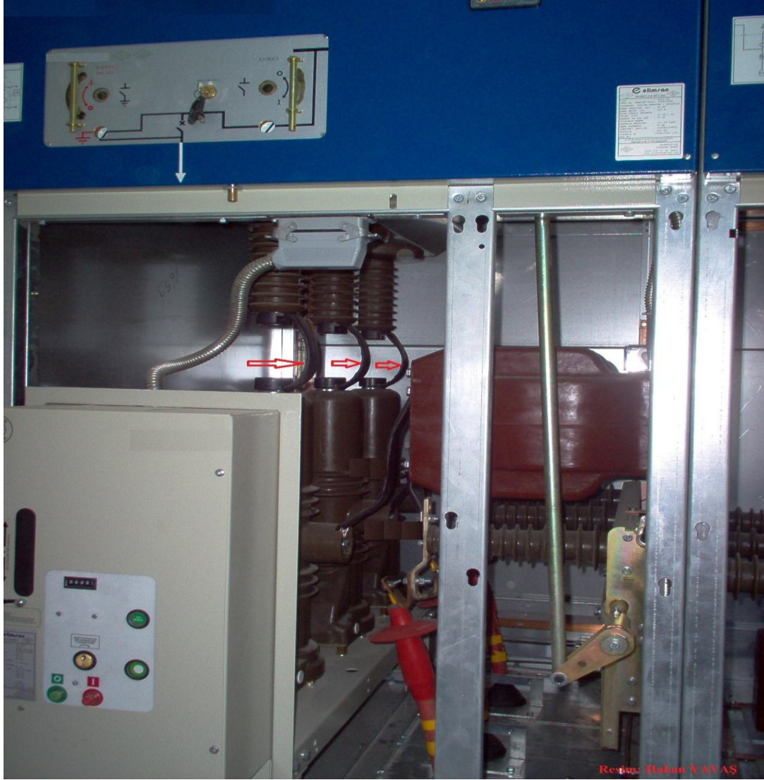
Resim 3.6: OG modüler hücre yük ayırıcısı bağlantıları
