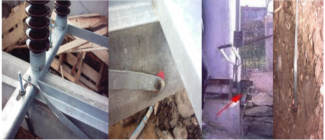
Resim 2.10: Harici tip ayırıcı topraklama şeridinin bağlantısı
