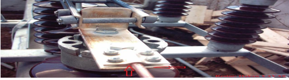
Resim 3.12: Harici tip ayırıcı iletken bağlantıları
