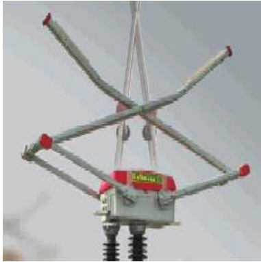
Resim 1.9: Ortadan açmalı ayırıcılar
