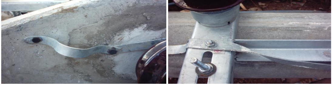
Resim 2.9: Harici tip ayırıcı topraklaması
