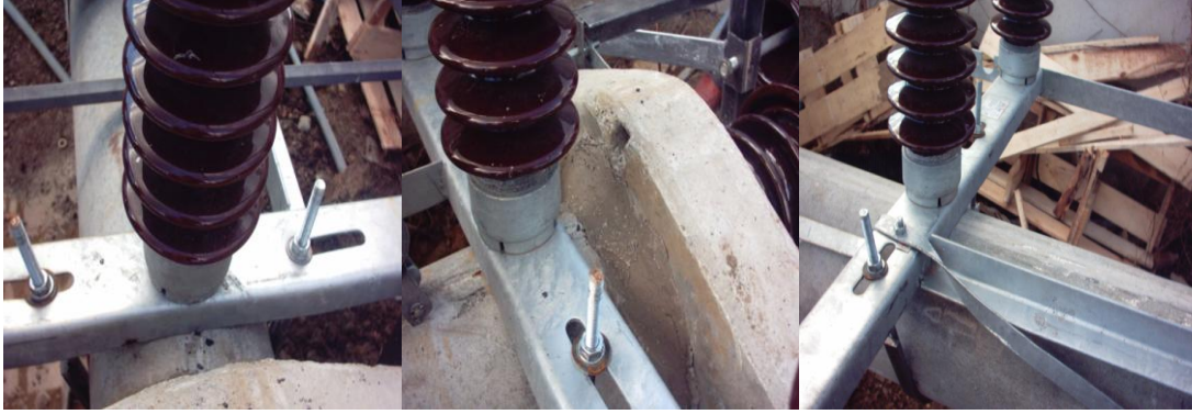
Resim 2.1: Ayırıcının beton direğe tutturulması
