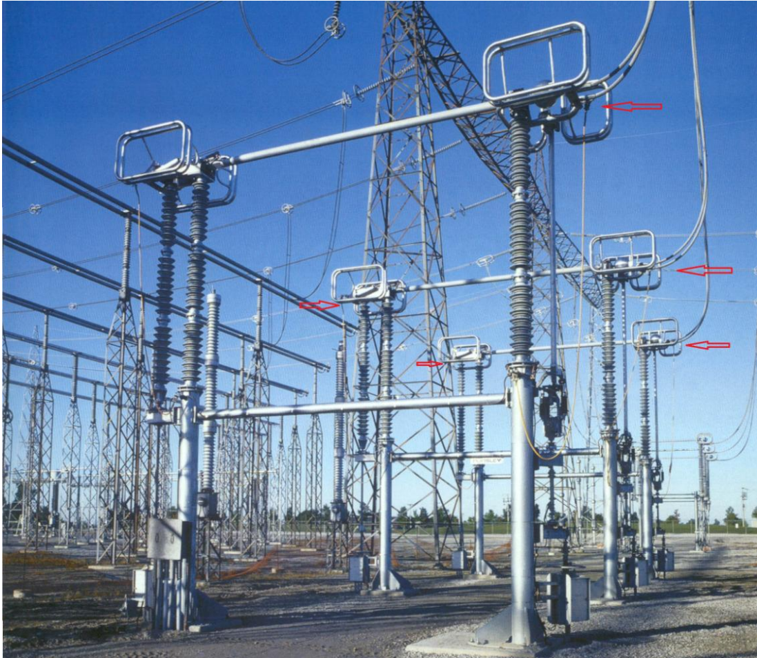
Resim 3.4: Şalt sahasında bulunan ayırıcı bağlantıları
