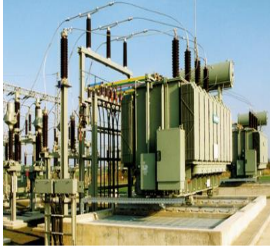
Resim 3.1: Şalt sahasında güç trafosu
