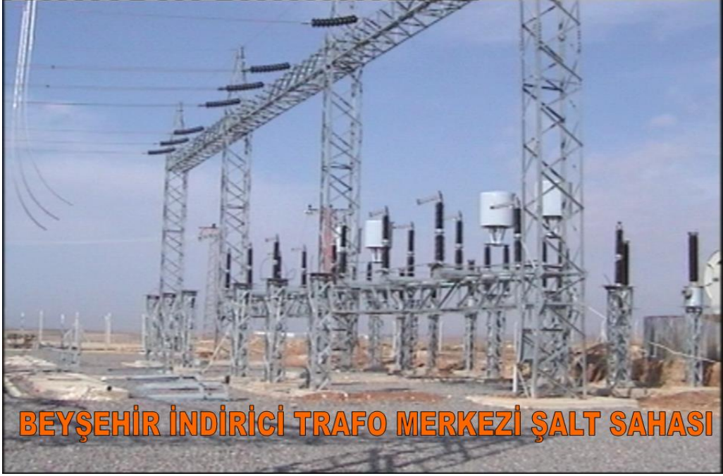
Resim 3.5: Kiriş tipi kurulmuş, Beyşehirtrafo merkezi şalt sahası
