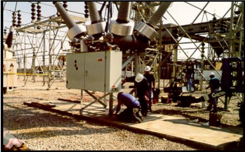
Resim 3.4: Bir şalt merkezindeki kesici montajı
