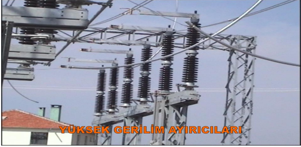
Resim 3.3: Bir trafo merkezindeki yüksek gerilim ayırıcılar
