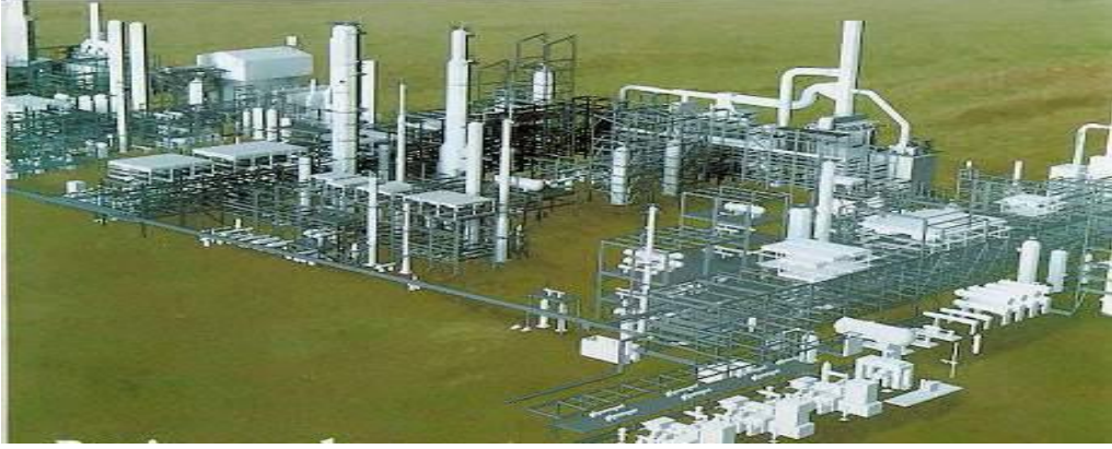
Resim 1.14: Bir Türk firması tarafından çölde kurulmuş dizel elektrik santrali (Sapugaskanda)
