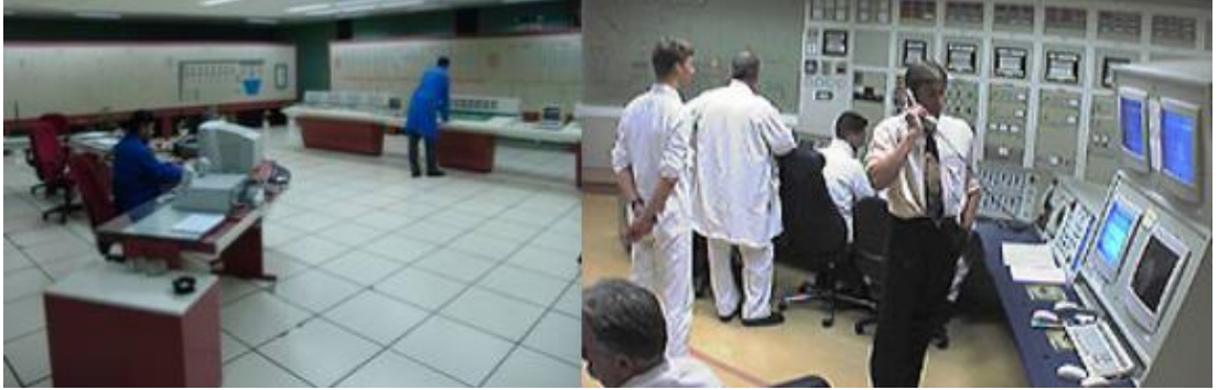
Resim 1.20: Atatürk Barajı hidroelektrik santrali kumanda odası
