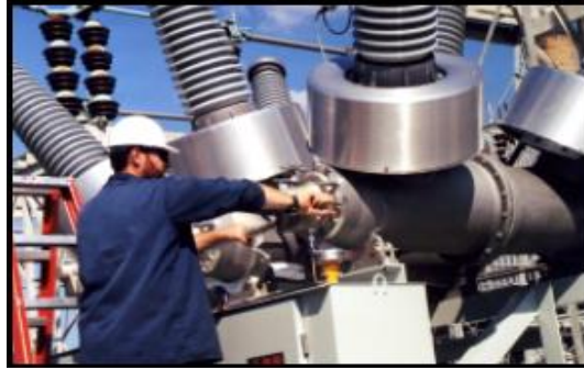
Resim 2.2: Kesicinin sahada montajı
