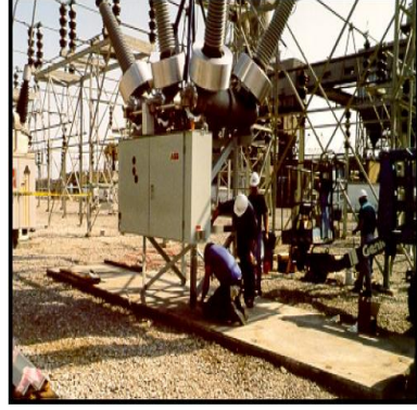
Resim 2.3: Bir santral şalt merkezindeki kesiciler ve montajı
