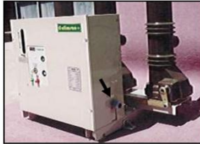
Resim 2.14: Kesicinin kablo bağlantı noktaları
