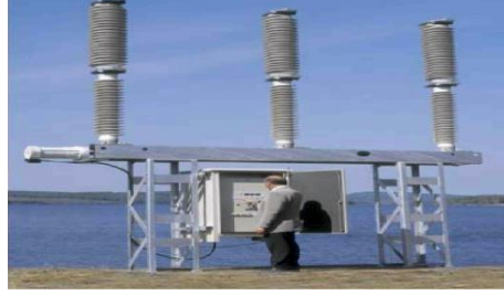
Resim 3.5: 154 Kv yüksek gerilim kesicisinin kumandası
