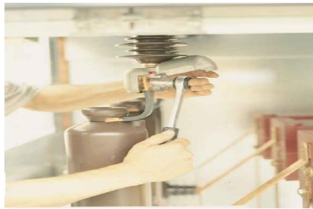
Resim 3.3: Kesici barasının bağlanması
