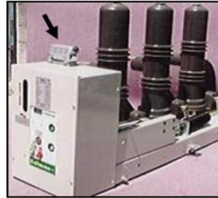
Resim 2.14: Kesicinin kablo bağlantı noktaları
