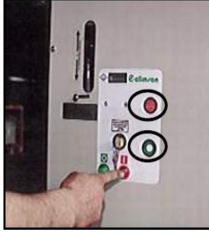
Resim 3.10: Kesicinin kapatılması
