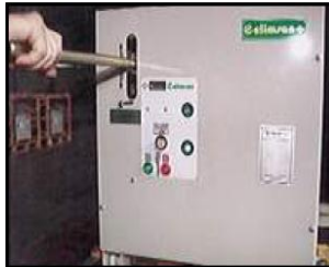
Resim 3.8: Kesicinin kurulması
