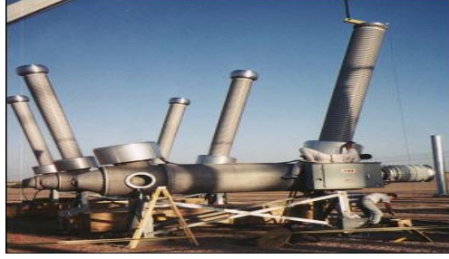
Resim 1.2: 550 kV yüksek gerilim kesici
