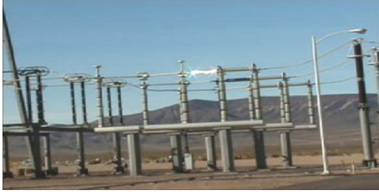
Resim 1.3: 500 kV'luk havalı kesicinin açma işlemi sırasında oluşan ark
