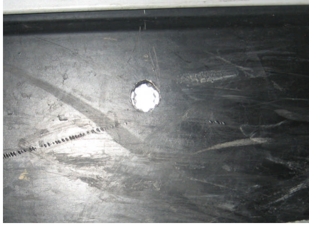
Resim 1.8: Yürüyen merdiven/yol optik sensör karşısında konumlandırılmış yansıtıcı ayna
