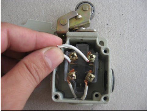
Kablo bağlantılarının elle kontrolü
