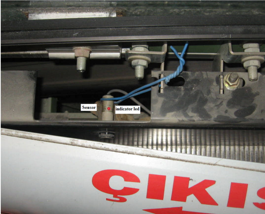
Resim 1.9: Optik sensörün etek sacı içerisindeki görünüşü
