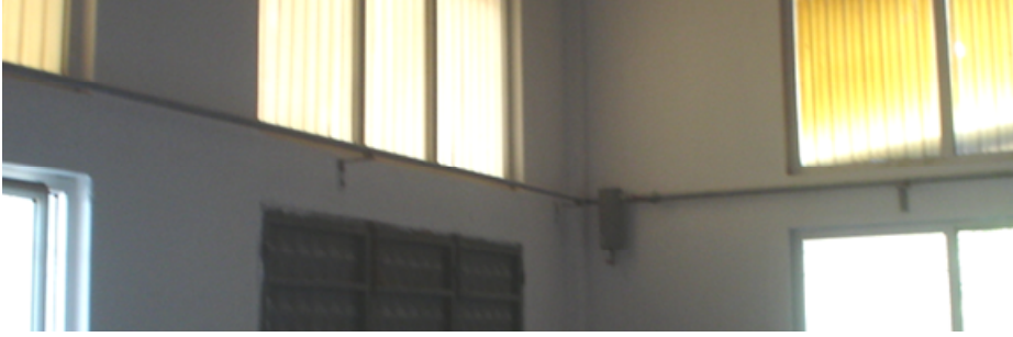
Şekil 1.24: Havanın dağıtımı; tavana yakın olmalı
