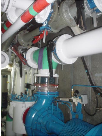
Resim 2.5: Balast pompası basış hattında bulunan kompensatör ve geri döndürmez vana
