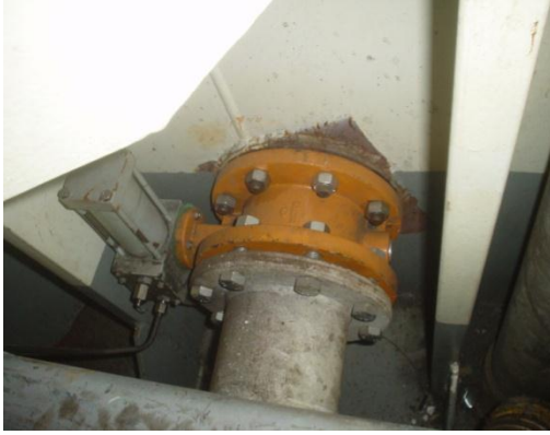
Resim 2.8: Uzaktan kumandalı pnömatik vana
