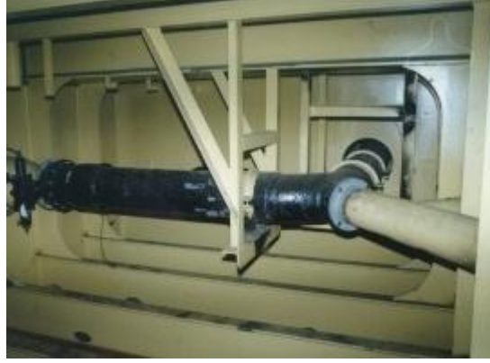
Resim 1.1: Balast tankı grup boru uygulaması
