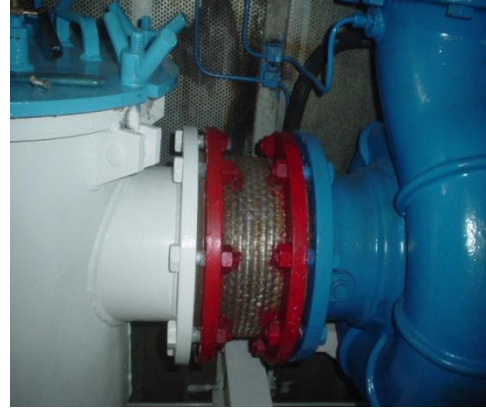
Resim 2.4: Balast pompası alıcı hattında bulunan kompensatör
