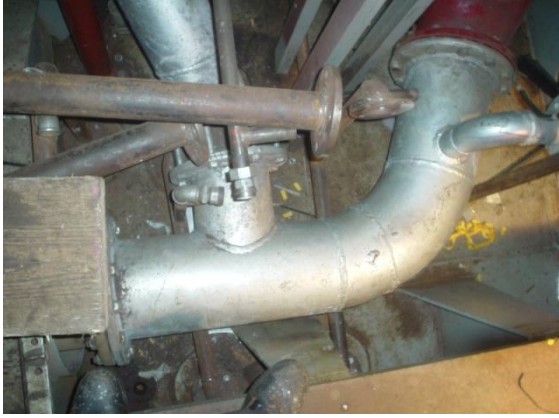
Resim 2.2: Ana deniz suyu hattından balast pompalarına ayrılan kollar
