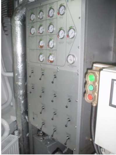
Resim 2.7: Uzaktan kumandalı pnömatik vanaların kontrol ünitesi ve vanalara giden hidrolik borular
