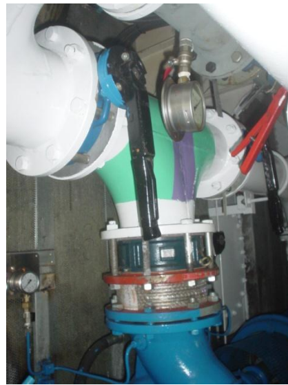
Resim 2.5: Balast pompası basış hattında bulunan kompensatör ve geri döndürmez vana
