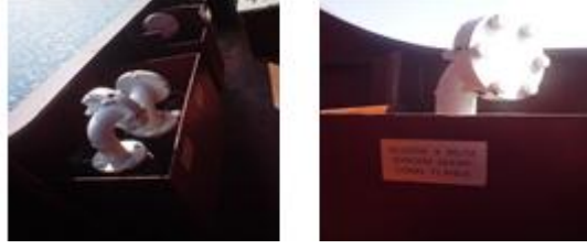
Resim 1.4: Güvertede bulunan makine dairesinde, pis su tankındaki sıvıyı limana boşaltmada kullanılan bağlantı
