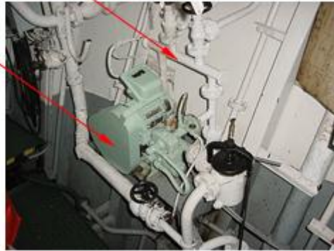
Resim 1.6: Makine dairesinde sintine separatörü
