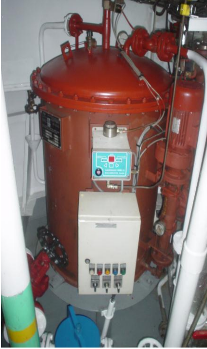
Resim 1.5: Makine dairesinde sintine separatörü
