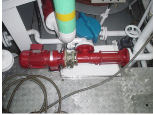
Resim 1.2: Makine dairesinde pis su pompası
