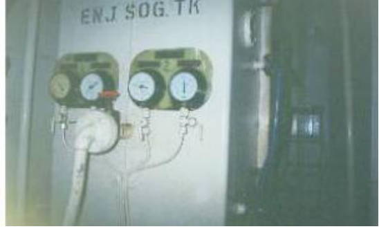
Enj. Soğutma tankı
