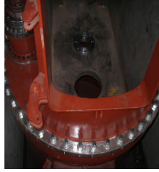
Resim 1.3: Kreynin fandeyşin bağlantısı
