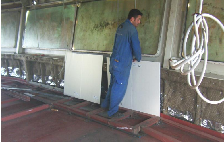
Resim 1.3: Kaptan köşkü yalıtım çalışması
