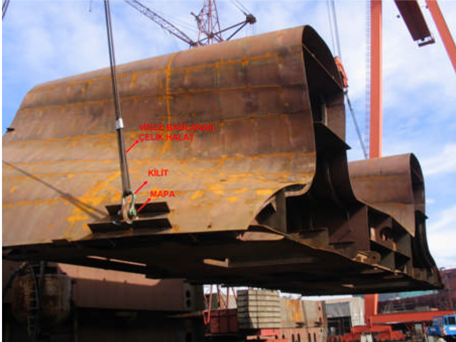
Resim 1.9: Blok kaldırma operasyonu
