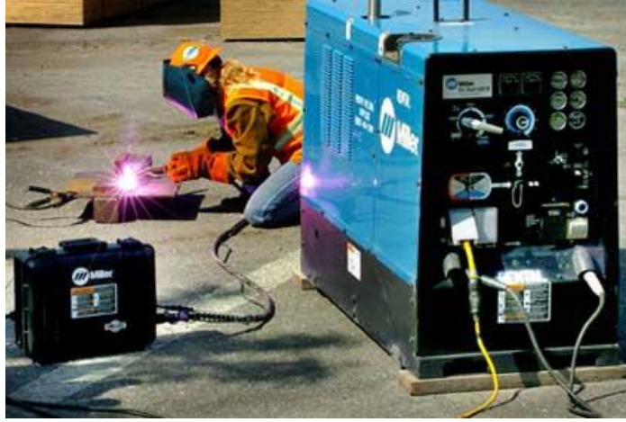
Resim 1.3: Jeneratör ark kaynak makinesi ve çalışma
