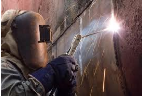
Resim 1.5: Kaynak pensiyile kavranmış elektrod ile aşağıdan yukarıya dik kaynak
