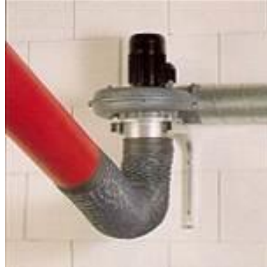
Resim 1.20: Duvara monte edilmiş emeç ile kaynak alanındaki zararlı gazların emilmesi
