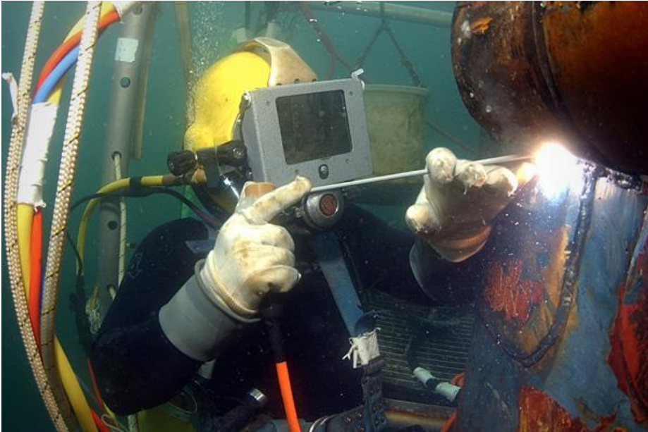
Resim 1.2: Gemi omurgasının su altında ergitme kaynağıyla onarılması
