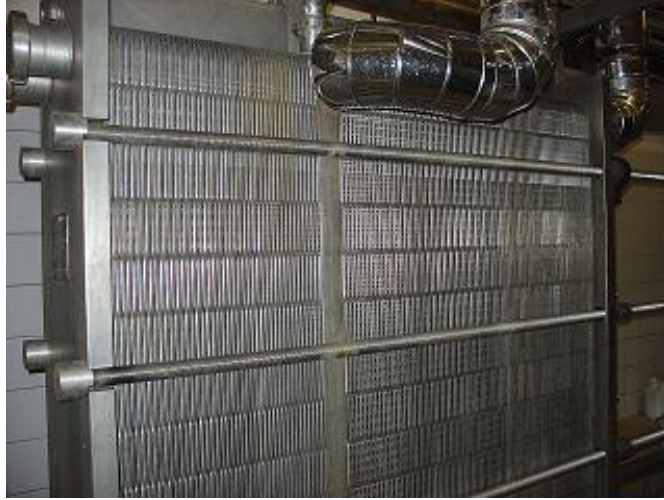
Resim 3.1: Salamura suyunun pastörize edildięi, titanyumdan yapılmış plakalı ısı deęiřtirici
