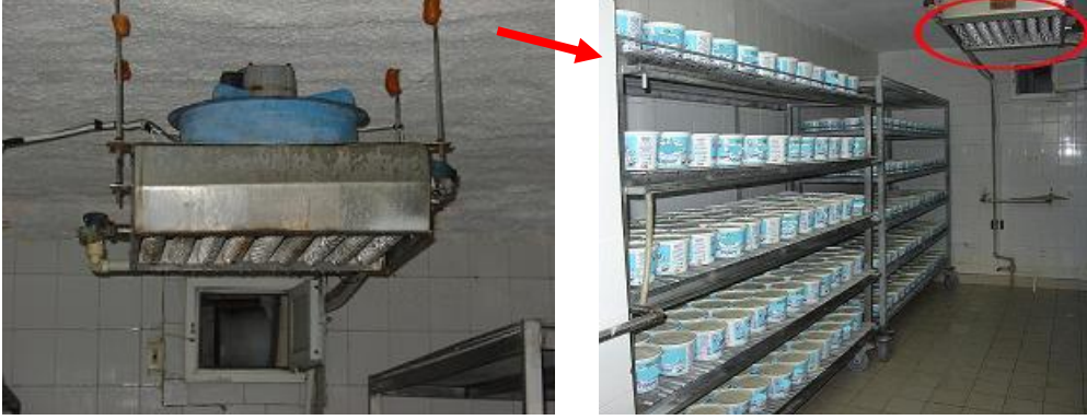
Resim 3.1: İnkübasyon odalarına yerleştirilen havalandırma sistemi
