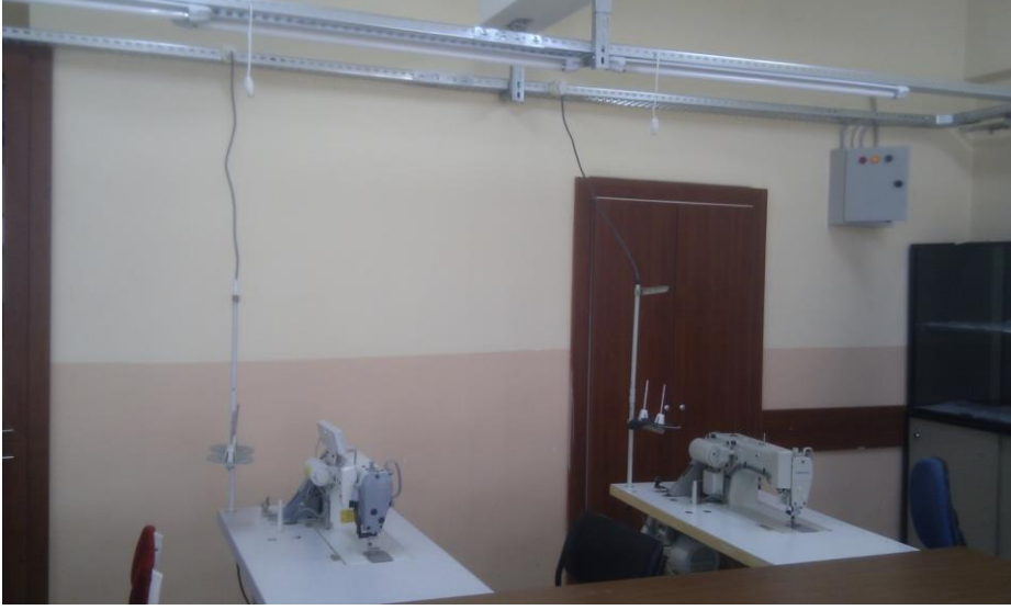
Resim 1.3: Atölyede elektrik donanımı
