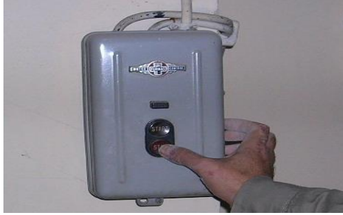
Resim 2.23: Start düğmesine basılması
