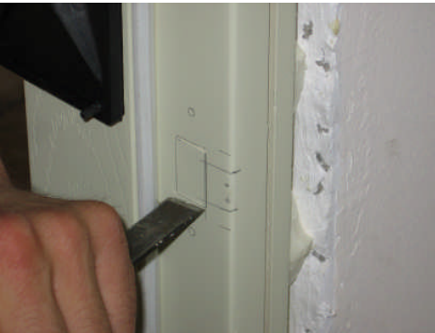
Resim 2.22: Kilit dil yuvasının boşaltılması
