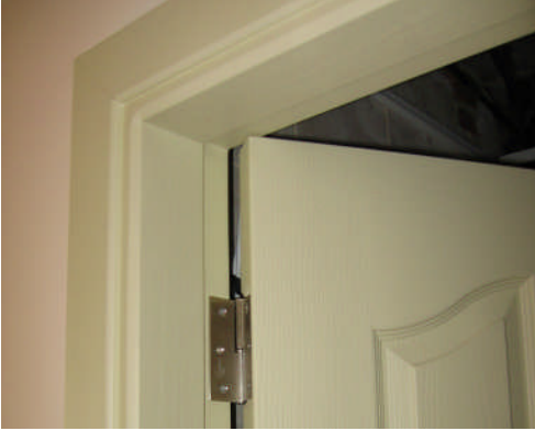
Resim 2.4: Kapı kanadının kasaya takılması
