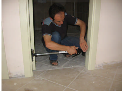
Resim 2.7: Sıkıştırma aparatının kasa alt boşluğuna yerleştirilmesi
