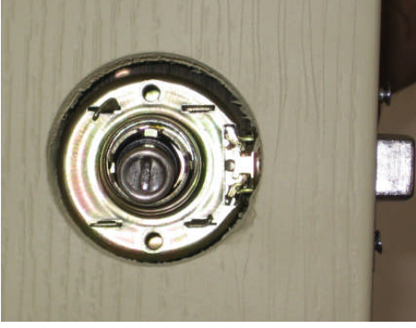
Resim 2.18: Kilidin yerine takılıp flaş ve vida ile sabitlenmesi
