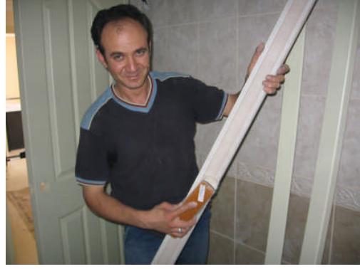
Resim 2.13 a,b: Pervaz boyunun testere ile kesilip pervaz üzerinden tozların fırça ile temizlenmesi
