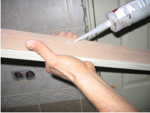
Resim 2.12 a,b: Silikon sürülen kapı üst pervazının yerine takılması
