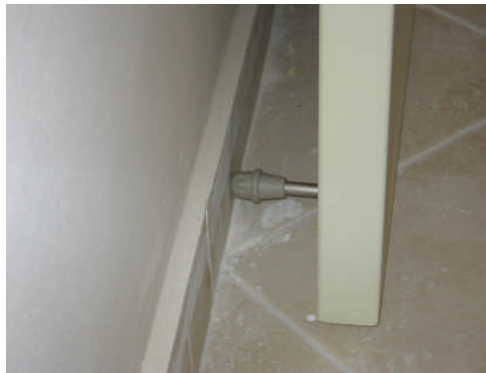
Resim 2.26: Kapı stobu takılmış kapı kanadı
