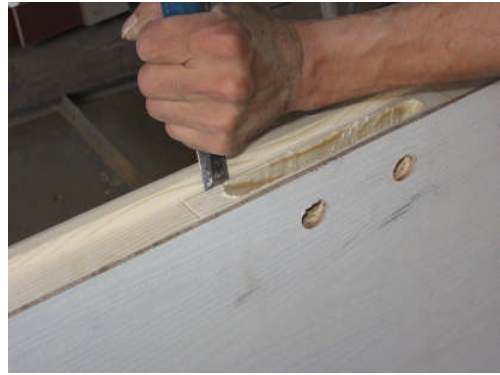
Resim 1.30 a,b,c,d,e,f: Kilit lamasının markalanması ve lama yerinin iskarpela ile boşaltılması
