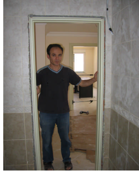
Resim 2.1: Kapı kasasının kapı boşluğuna yerleştirilmesi
