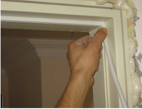
Resim 2.24 a,b,c,d: Kapı kasasına kapı contasının takılması
