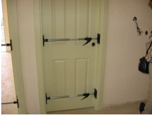
Resim 2.7: Sıkıştırma aparatının kasa alt boşluğuna yerleştirilmesi
