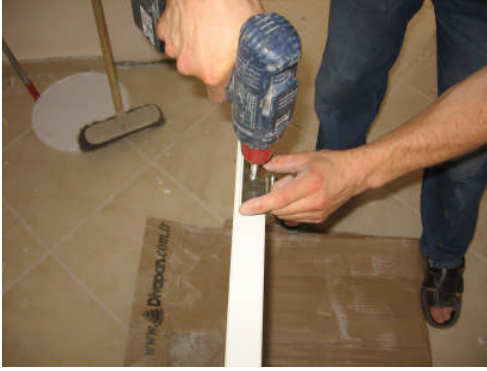
Resim 2.3: Kapı kasası ve kanadına menteşenin takılması
