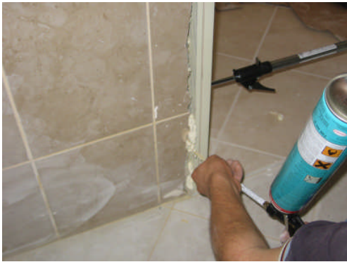
Resim 2.9: Kapı kasası-duvar boşluğunu, poliüretan köpük ile doldurma ve kasayı sabitleme
