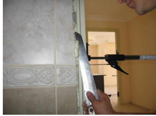
Resim 2.11: Pervaz öncesi kama ve köpük fazlalıklarının kesilmesi
