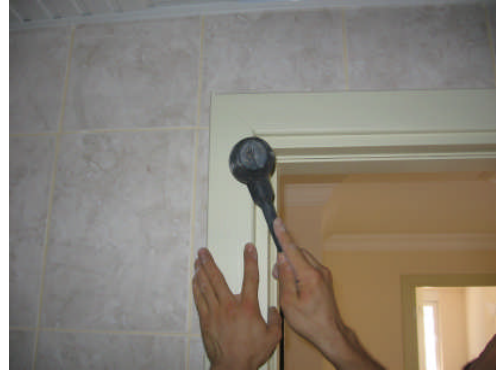
Resim 2.14 a,b: Silikon sürülen yan pervazların yerine takılması
