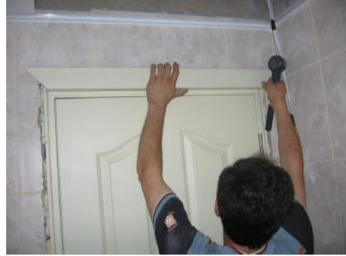
Resim 2.12 a,b: Silikon sürülen kapı üst pervazının yerine takılması
