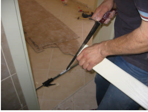
Resim 2.13 a,b: Pervaz boyunun testere ile kesilip pervaz üzerinden tozların fırça ile temizlenmesi
