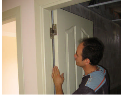
Resim 2.4: Kapı kanadının kasaya takılması
