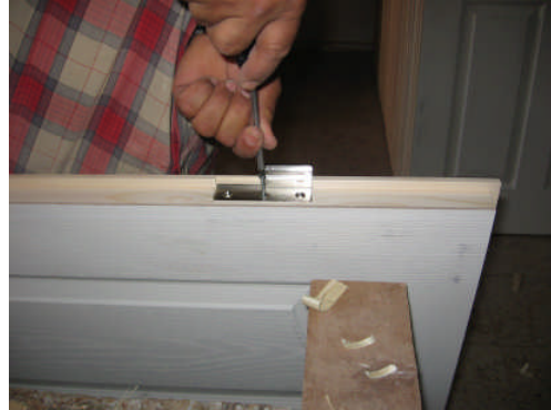
Resim 1.23: Menteşenin yerine alıştırılıp vida ile sabitlenmesi
