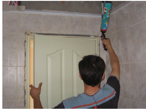
Resim 2.9: Kapı kasası-duvar boşluğunu, poliüretan köpük ile doldurma ve kasayı sabitleme
