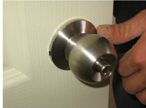
Resim 2.20: Çalışması kontrol edilen kilit dilinin yerine vida ile sabitlenmesi
