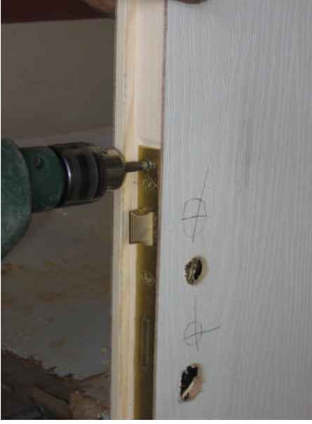
Resim 1.31: Kilidin yerine vida ile sabitlenmesi ve kol demirinin takılması
