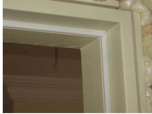
Resim 2.24 a,b,c,d: Kapı kasasına kapı contasının takılması
