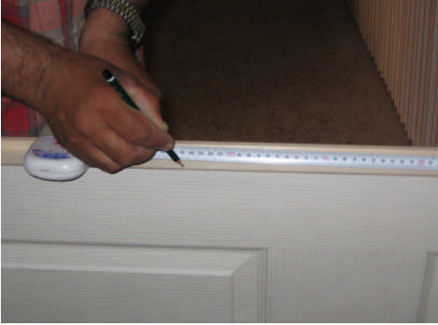
Resim 1.26: Kapı kanadı kilit yerinin markalanması
