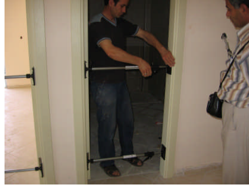
Resim 2.7: Sıkıştırma aparatının kasa alt boşluğuna yerleştirilmesi
