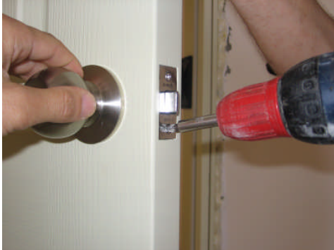
Resim 2.20: Çalışması kontrol edilen kilit dilinin yerine vida ile sabitlenmesi
