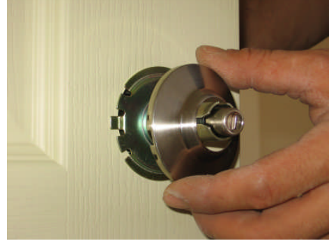
Resim 2.19: Kilit aynasının ve tokmağının yerine takılması
