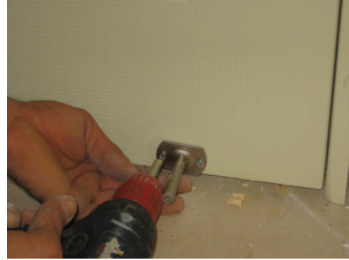
Resim 2.25: Kapı stop yerinin markalanması ve stobun kanada takılması
