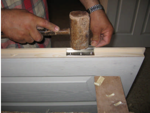
Resim 1.23: Menteşenin yerine alıştırılıp vida ile sabitlenmesi
