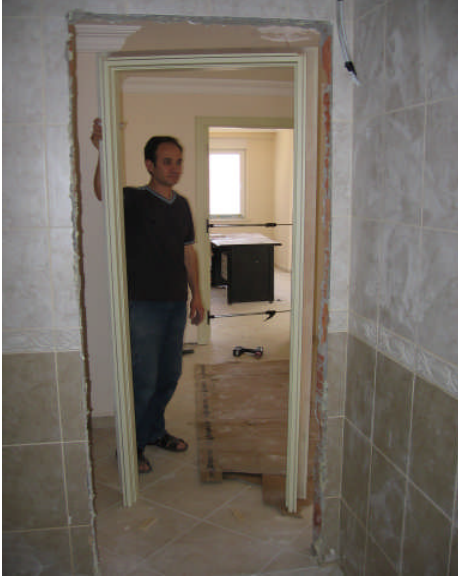
Resim 2.1: Kapı kasasının kapı boşluğuna yerleştirilmesi
