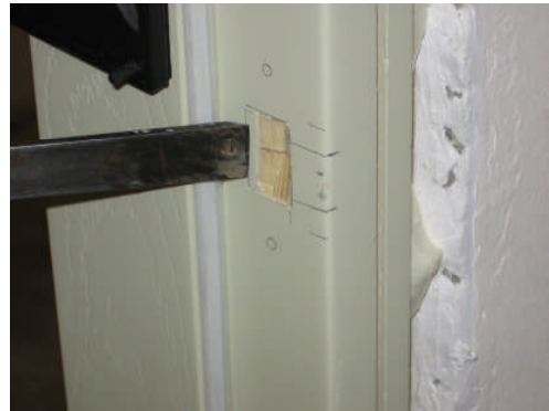
Resim 2.22: Kilit dil yuvasının boşaltılması
