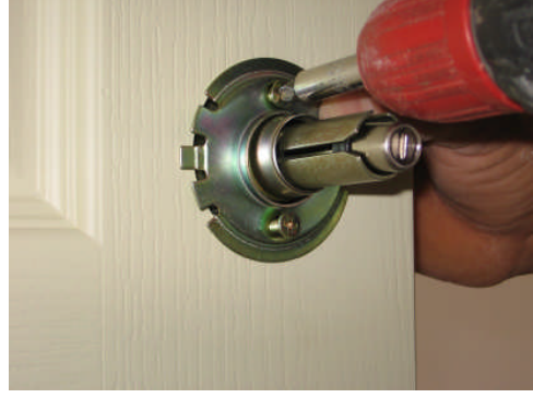
Resim 2.18: Kilidin yerine takılıp flaş ve vida ile sabitlenmesi
