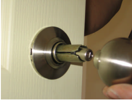
Resim 2.19: Kilit aynasının ve tokmağının yerine takılması
