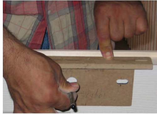
Resim 1.26: Kapı kanadı kilit yerinin markalanması
