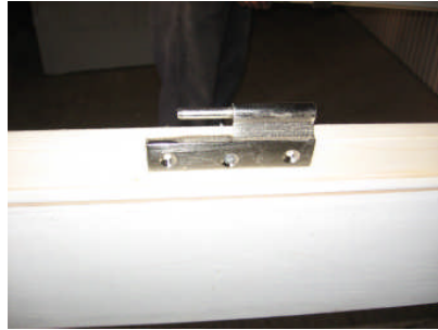
Resim 1.25: Kapı kasasına takılmış lambalı menteşe
