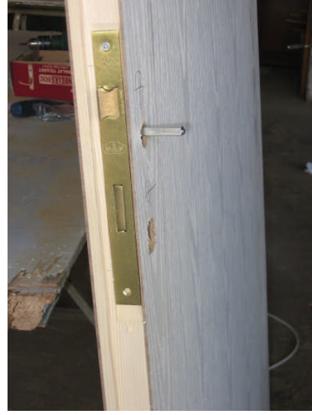
Resim 1.31: Kilidin yerine vida ile sabitlenmesi ve kol demirinin takılması
