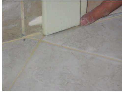
Resim 2.15 a,b,c,d: Pervaz tabanının su ve neme karşı silikon sürülerek izole edilmesi
