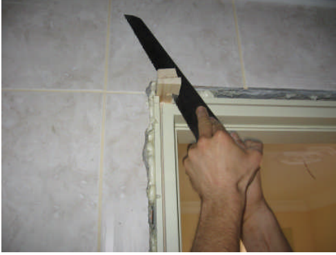
Resim 2.11: Pervaz öncesi kama ve köpük fazlalıklarının kesilmesi
