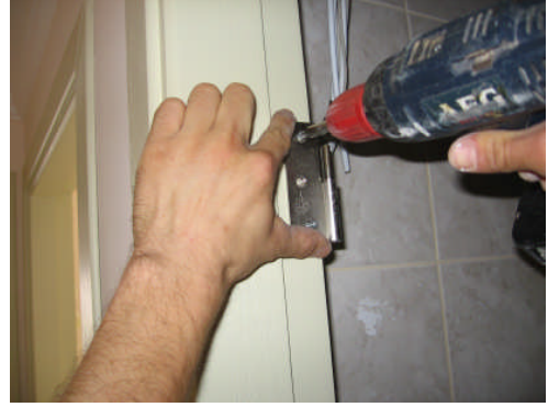
Resim 2.3: Kapı kasası ve kanadına menteşenin takılması
