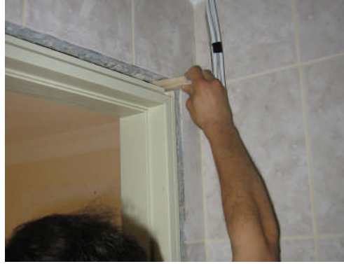
Resim 2.2: Kapı kasasının kama ile sıkıştırılması
