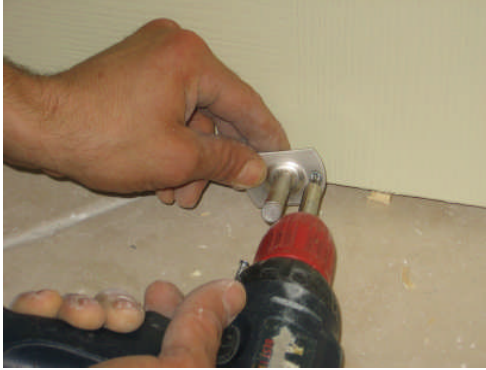
Resim 2.25: Kapı stop yerinin markalanması ve stobun kanada takılması
