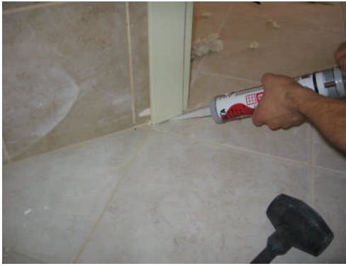
Resim 2.15 a,b,c,d: Pervaz tabanının su ve neme karşı silikon sürülerek izole edilmesi
