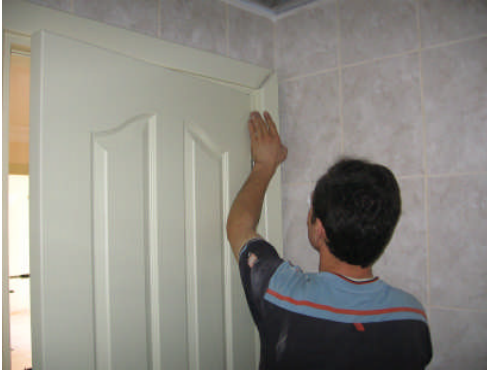
Resim 2.14 a,b: Silikon sürülen yan pervazların yerine takılması
