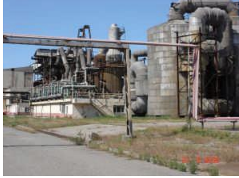
Resim 2.3: Sülfürik asit üretim tesisi
