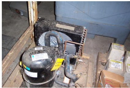
Resim 1.4: Freon gazı içeren soğutma kompresörü
