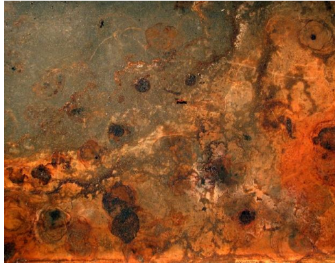
Resim 3.3: Korozyona uęramıř metal yzey
