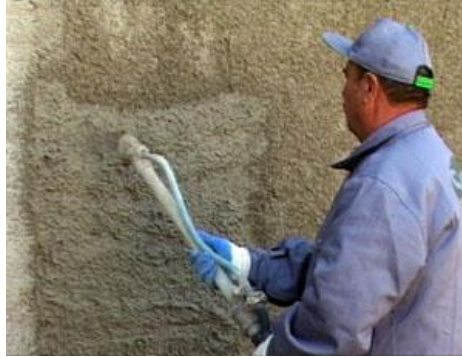
Resim 2.5: Hazır sıva uygulaması
