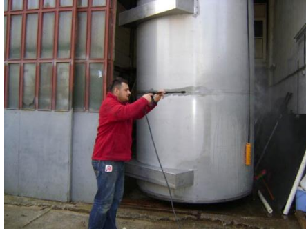
Resim 1.4; Basınçlı su ile yüzey temizleme
