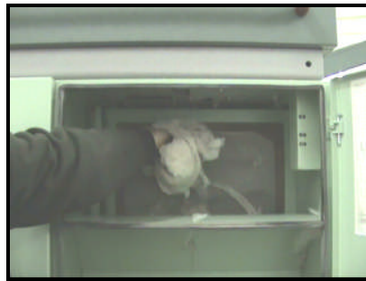
Resim 1.39: Telef filtresi eleğinin temizlenmesi
