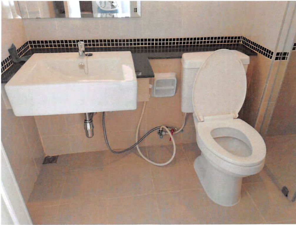
งานรื้อถอนพร้อมติดตั้งโถชักโครกเดิม
