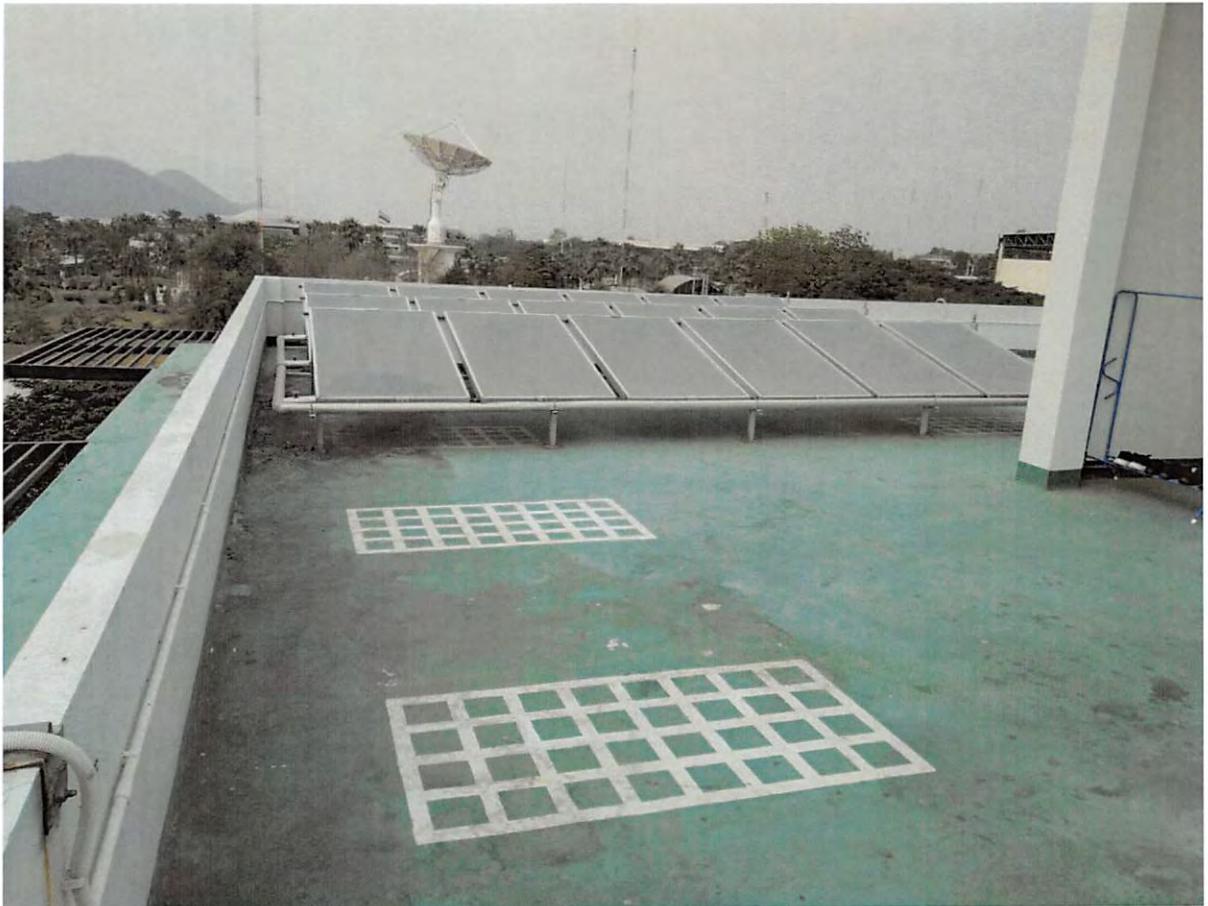
งานซ่อมแก้ไขพื้น คสล. ชั้นดาดฟ้าอาคาร HORIZON
