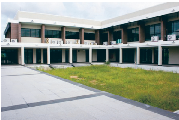
ภาพกว้างบริเวณส่วนกลางของอาคาร
