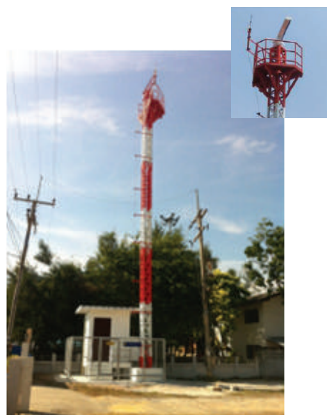
เสารับส่งสัญญาณ HF-RADAR
