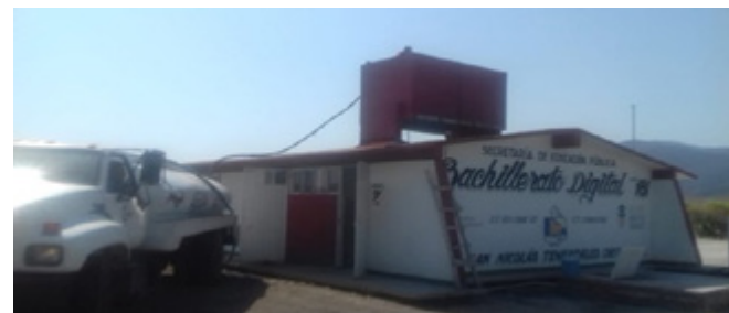
Bachillerato digital de San Nicolás Tenexcalco
