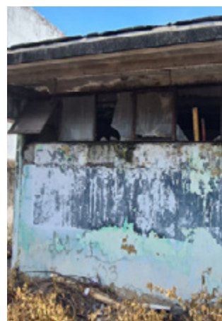
Biblioteca municipal de Escape de Lagunillas
