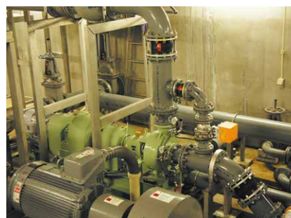
「東部地域広域水道企業団施設内小水力発電所」（山梨県大月市）に設置されたマイクロ水力発電設備。維持・管理を含めて低コストかつ発電効率の高いシステムを採用
