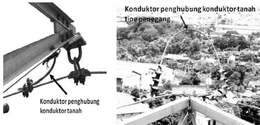
Gambar 30 Konduktor penghubung konduktor tanah
