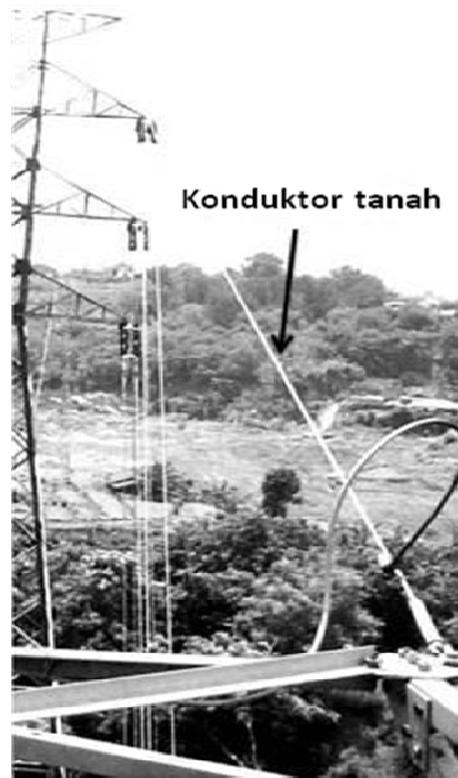
Gambar 29 Konduktor tanah
