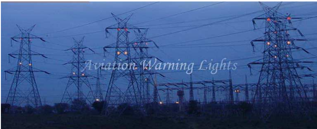
Gambar 60 Lampu penerbangan tower
