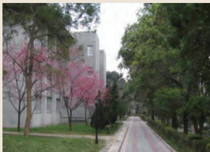
95-96年將原有水泥步道改為透水磚鋪設
