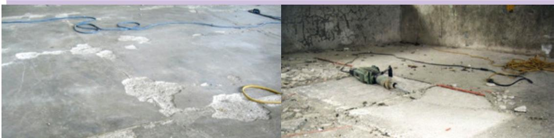
明德樓修繕，打除原有損壞的水泥地板。
