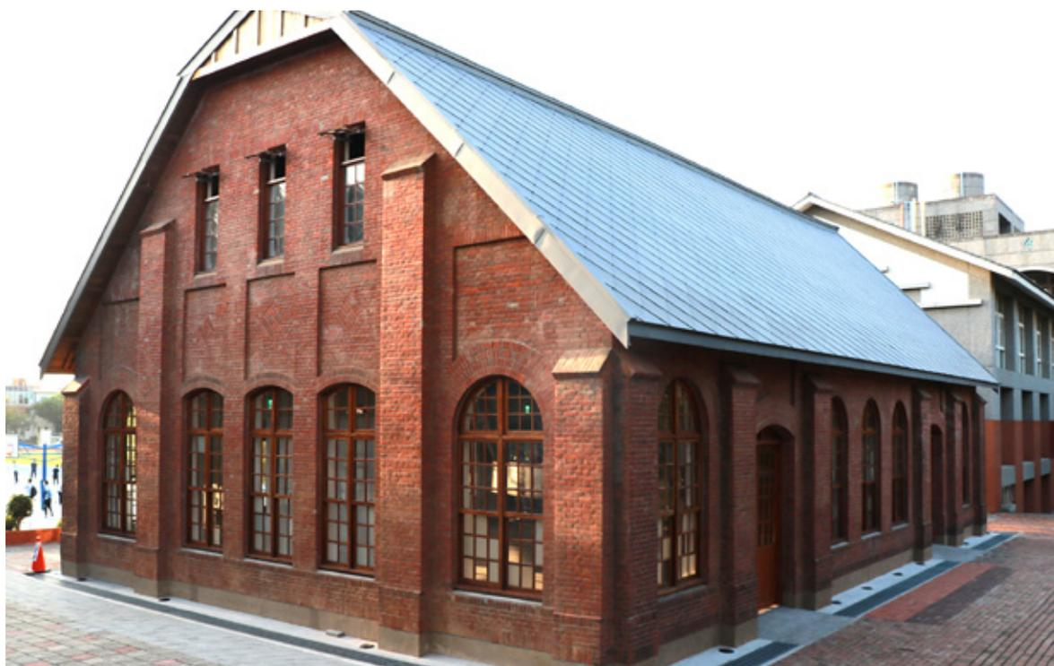
本市定古蹟建築之主要結構體，係主體兩坡式洩水屋頂、平測入口大門、紅磚疊砌搭配扶壁柱牆體結構、偶同柱式與腰折小屋的混合木屋架構造。
